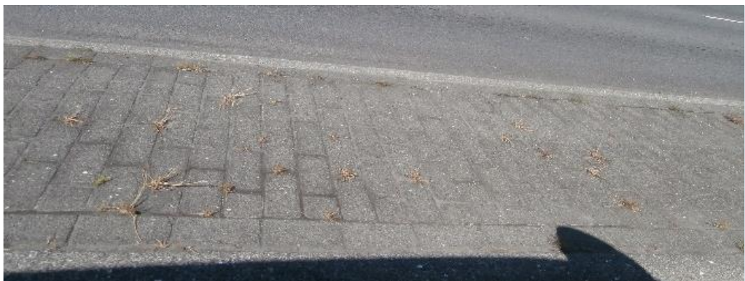
Mynd 5.5 Mynd tekin af gatnamótum Miklubrautar og Grensás 9 dögum eftir að SPUMA aðferðin var notuð. Mynd tekin 23.07, 2015.
