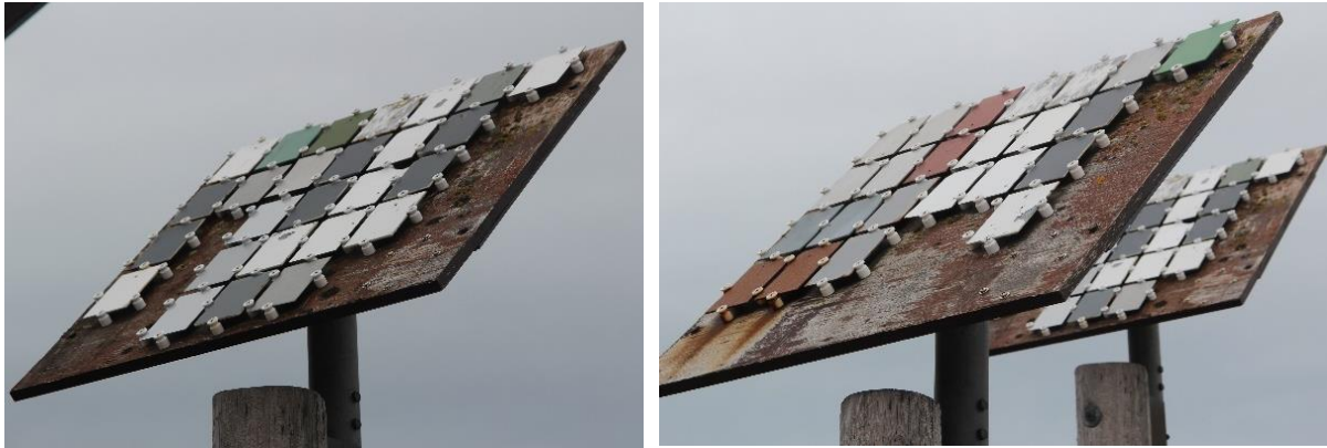
MYND 2 Tæringarrekkar í Reykjavík.
