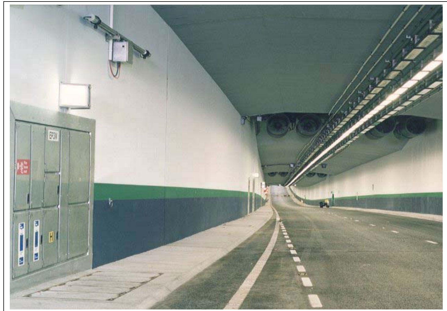
Mynd 2.17 Horft eftir tveggja akreina botngöngum.
