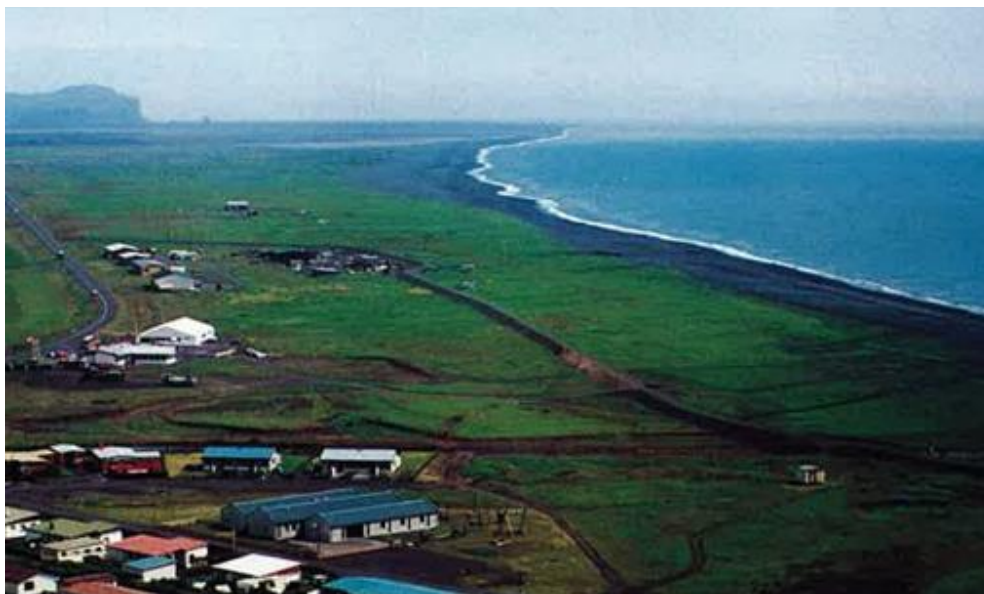
Mynd 2 Flóðvarnargarður neðan við byggðina í Vík byggður sumarið 1995. Þarna er enn langt frá fjörुकambi að flóðavörn. Úr Sjónvarnarskýrslu Vita- og hafnamálastofnunar frá 1995.
