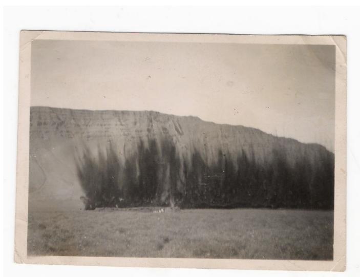
Mynd 29 - Notast var við dínamít við framræslu í Reykhólasveit. Mynd frá Hirti Þórarinssyni.
