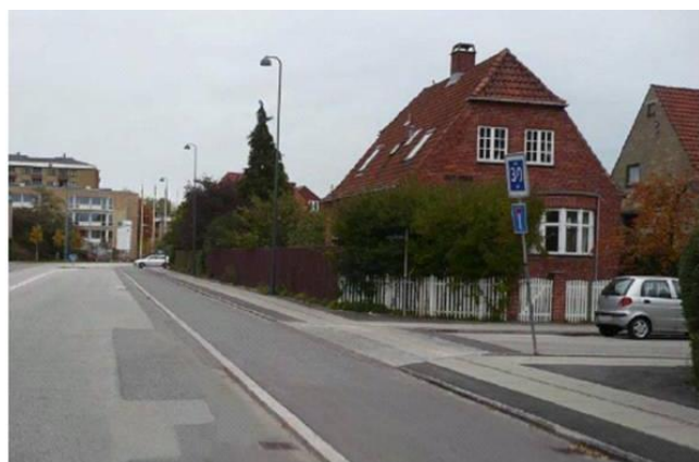
Mynd 15 Hjólástígar í Danmörku þétt upp við aðalgötu, óbrotinn fram hjá þvergötu. Mynd úr leiðbeiningum dönsku vegagarðarinnar um gatnamót (Vejdirektoratet. 2010).
