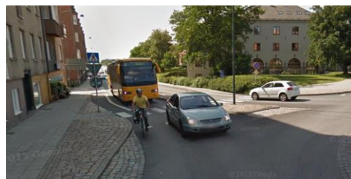
Mynd 7 Útfærsla 4, hringtorg. Umferð hjólandi færð saman við umferð akandi með hjólarein 20-30 m áður en komið er að hringtorgi. Akandi og hjólreiðamenn deila rými innan hringtorgsins (ekki hjólarein) ( www.maps.google.com ).
