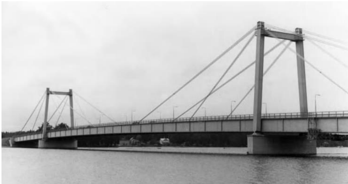
Mynd 2.1 Strömsundsbrúin hafði mikil áhrif á hönnun stagbrúa og oft nefnd sem fyrsta nútíma stagbrúin (Gimsing og Georgakis, 2011)
