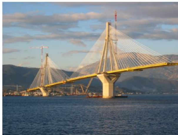
Mynd 2.5 Rion-Antirion brúin á byggingarstigi, hver turn er hannaður sem sjálfstæð eining sem geti staðið ein og sér (Infanti o.fl., 2004).
