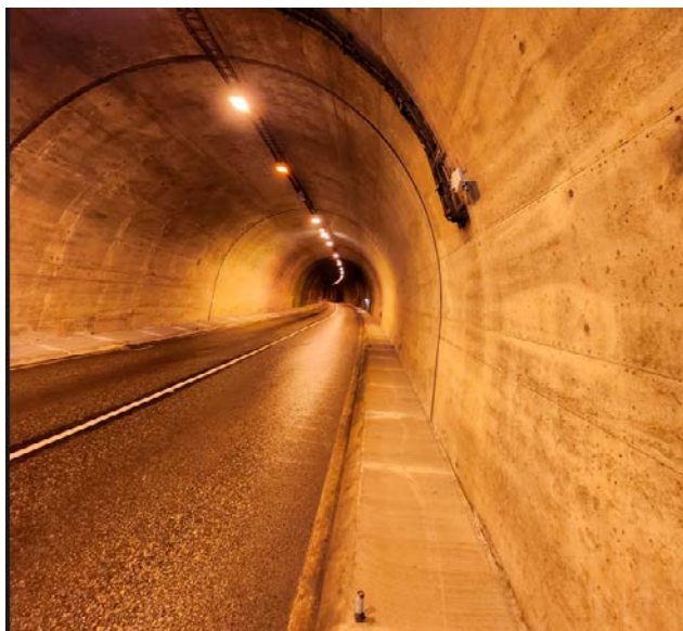
↑ Almannaskarðsgöng. Hér er búið að steypa kantstein og axlir í göngunum.
