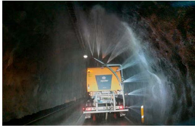
↑ Jarðgöng eru reglulega þrífir enda mikil óhreinindi sem setjast í sprautusteypunum.
