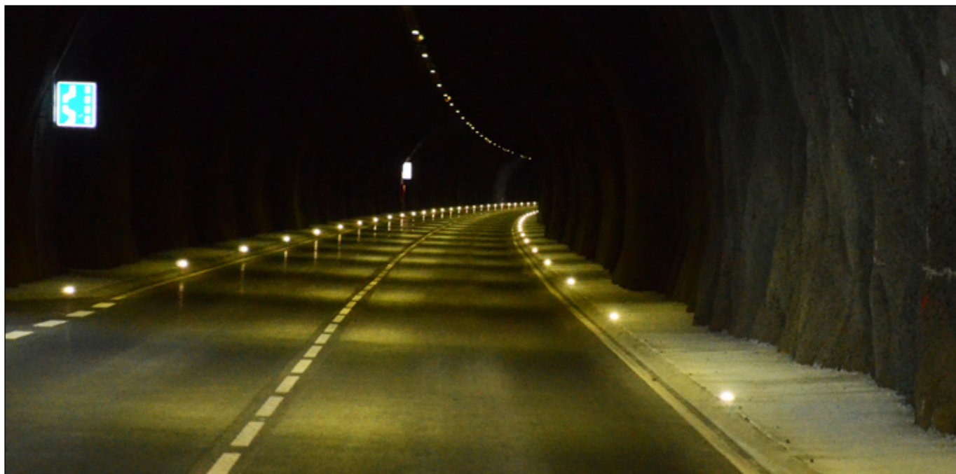
Norðfjarðargöng, kantlýsing sambærileg við lýsingu sem sett verður í Hvalfjarðargöng.
