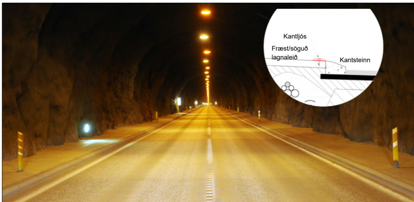
Hvalfjarðargöng, kantlýsing verður sett í staðinn fyrir vegstíkur með endurskini..
