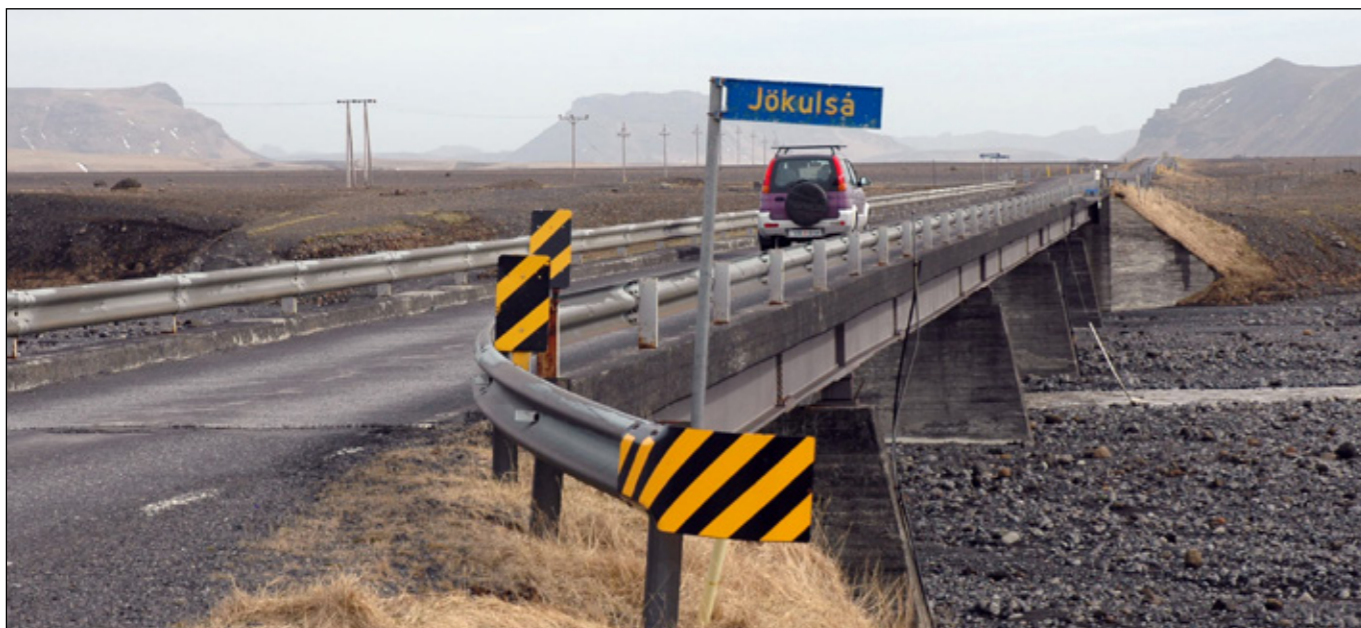
Brúin yfir Jökulsá á Sólheimasandi „er hálfgerður vandræðagripur“ segir Jón Rögnvaldsson, enda eina einbreiða brúin á leiðinni frá Reykjavík og austur fyrir Kirkjubæjarklaustur. Þessi brú var hins vegar kærkomið mannvirki og leysti af gamla ónýta brú þegar Jón hannaði hana 1967.
