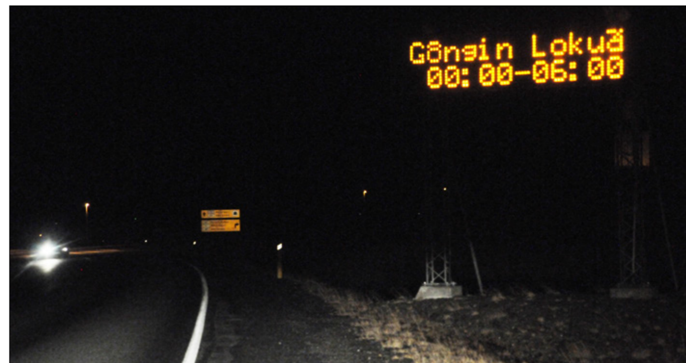
Ljósaskilti við Hvalfjarðargöng greina frá lokun ganganna. Í þessu tilviki vegna þrifa ganganna að nóttu til.
