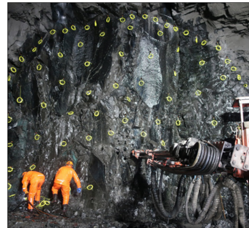
Undirbúningur fyrir sprengingu í Dýrafjarðargöngum 17. febrúar 2018.
