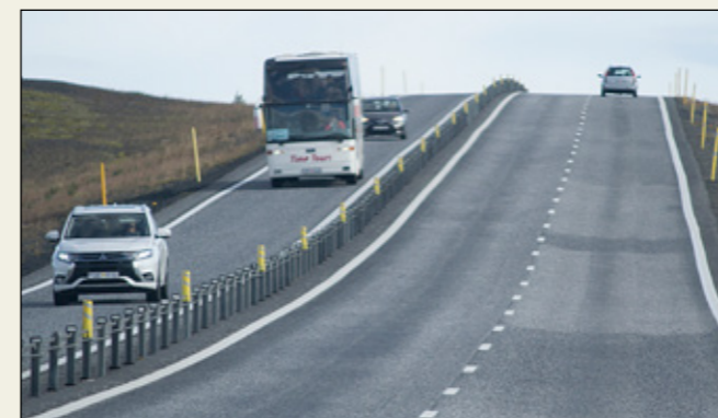
Hringvegur (1) (Suðurlandsvegur) við Litlu kaffistofuna. „Framúrakstursrein“ á 2+1 vegi, „þríreinungur“.
