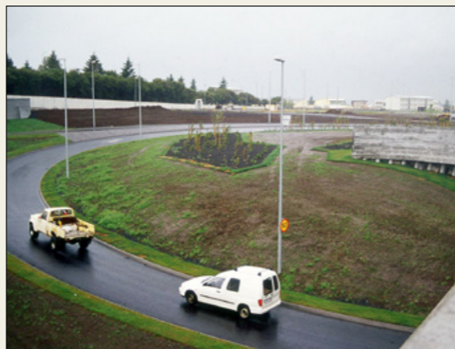
Mislæg gatnamót Reykjanesbrautar og Kaldárselsvegar, „rampi“. Myndin er tekin 2004, stuttu eftir að lokið var við framkvæmdina.
