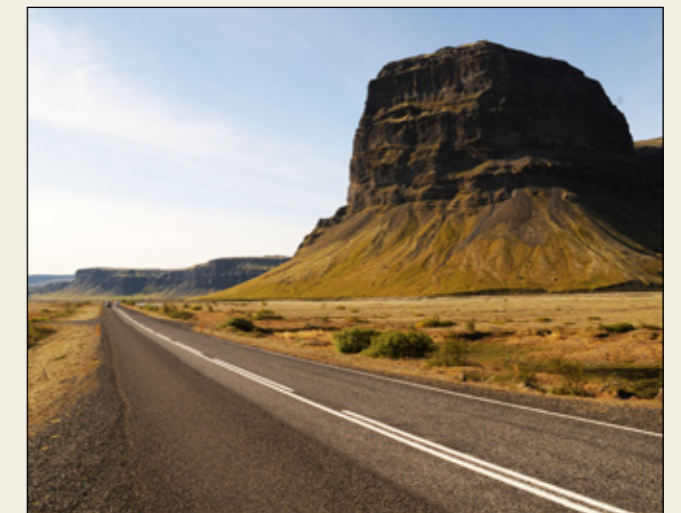
Hringvegur (1), (Suðurlandsvegur) við Lómagnúp, „tvíreinungur“ með „kantræmu“.
