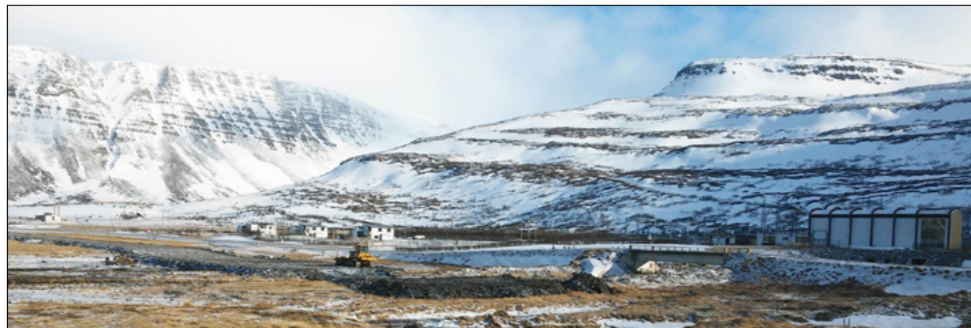
Dýrafjarðargöng í Arnarfirði. Unnið við vegagerð við stöðvarhús Mjólkárvirkjunar 4. mars 2018.
