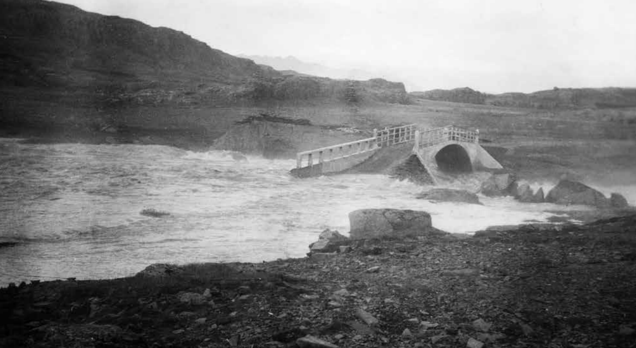
Fyrsta útgáfan af brúnni yfir Kolgrímu frá 1935 í flóði 21. ágúst árið 1945. Þarna má sjá steypugarðinn, sem brúar-smiðurinn kallaði svo, ofan straums á vinstri hönd (sjá rammagrein í næstu opnu) en til hægri var venjulegur brúarvængur. Einnig má sjá hvernig vegurinn hefur legið á jarðfyllingu inn á brúna.
