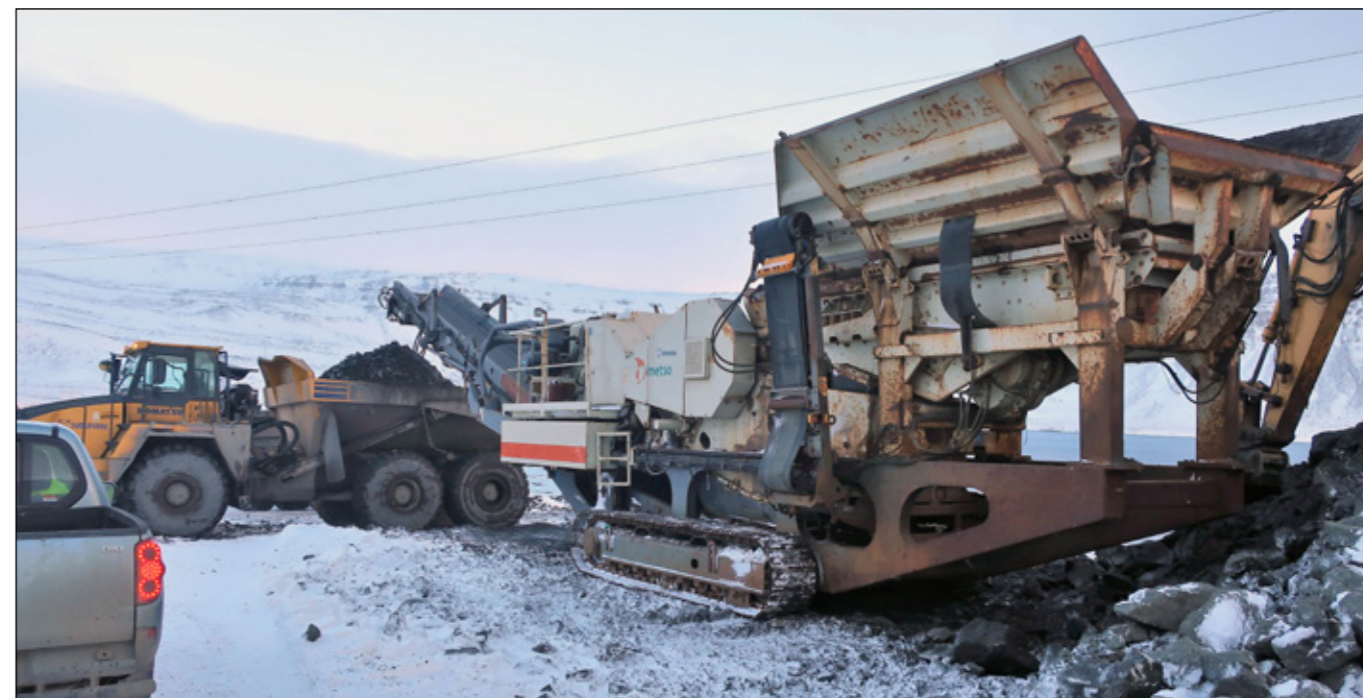
Dýrafjarðargöng, kjaftbrjótur kominn á svæðið 11. mars 2018. Kjaftbrjótinn notar verktaki til að brjóta niður efni sem kemur úr göngunum í smærri og þægilegri kornastærðir til að nota til að viðhalda vinnuvegi í göngunum.
