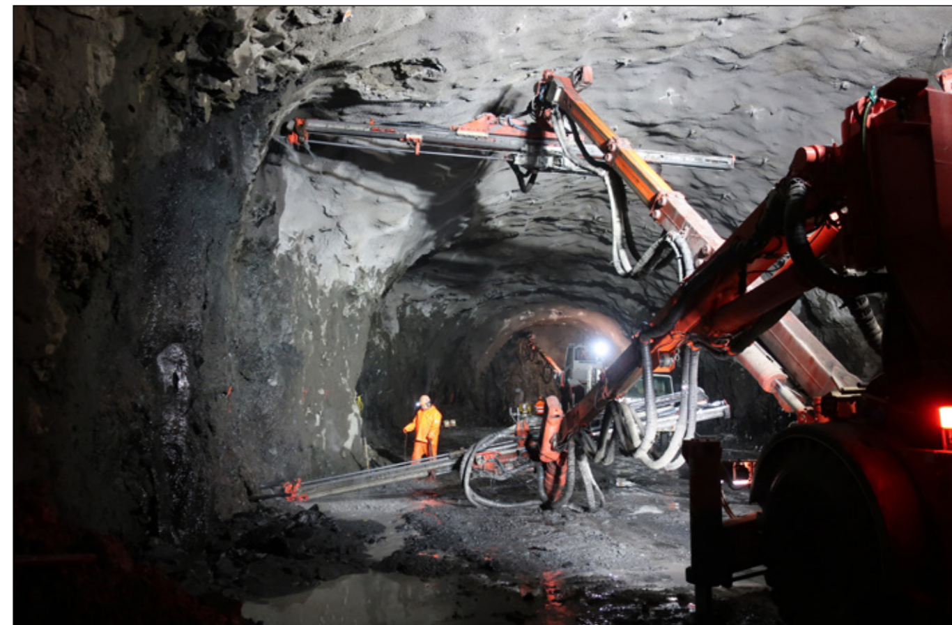
Tveir borar við vinnu í Dýrafjarðargöngum 27.10.2017. Bak við manninn í gula gallanum sést í staðinn þar sem snúningsútskot með sandgeymslu var grafið.
