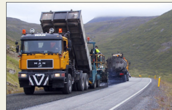
Klæðing lögð á Vestfjarðaveg (60) í Tungudal við Ísafjörð árið 2003. Mynd: Pétur Pétursson.
