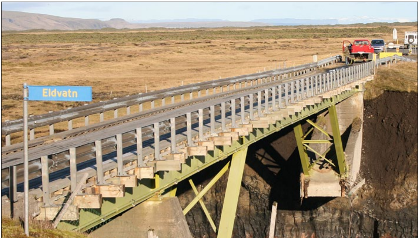
Núverandi brú á Eldvatni er með mjög skert burðarþol eftir að það gróf undan eystri stöplinum í hlaupi 2015.
