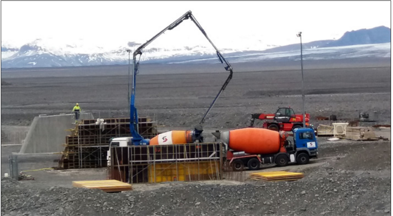
Steypuvinna við Morsá miðvikudaginn 4. maí 2016. Brúavinnuflokkur Vegagerðarinnar frá Vík. Ljósmynd: Sveinn Þórðarson.
