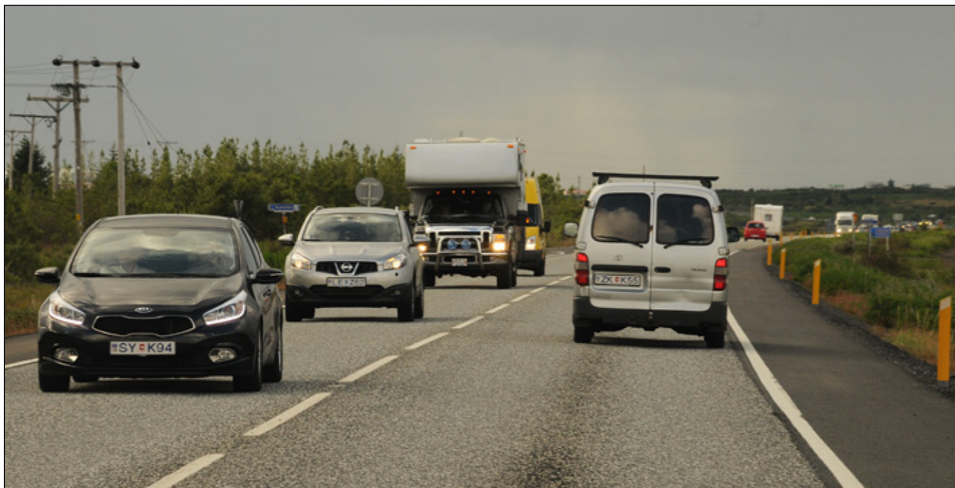
Hringvegur (1), Suðurlandsvegur, við Reykjavík.
