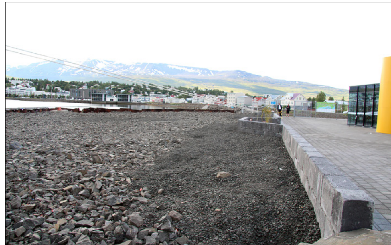
Mynd að ofan. Stækkun Oddeyrarbryggju frá 2014. Steypa og malbikun þekju hefur nú verið boðin út ásamt steypu kantbita, sjá niðurstöður.
