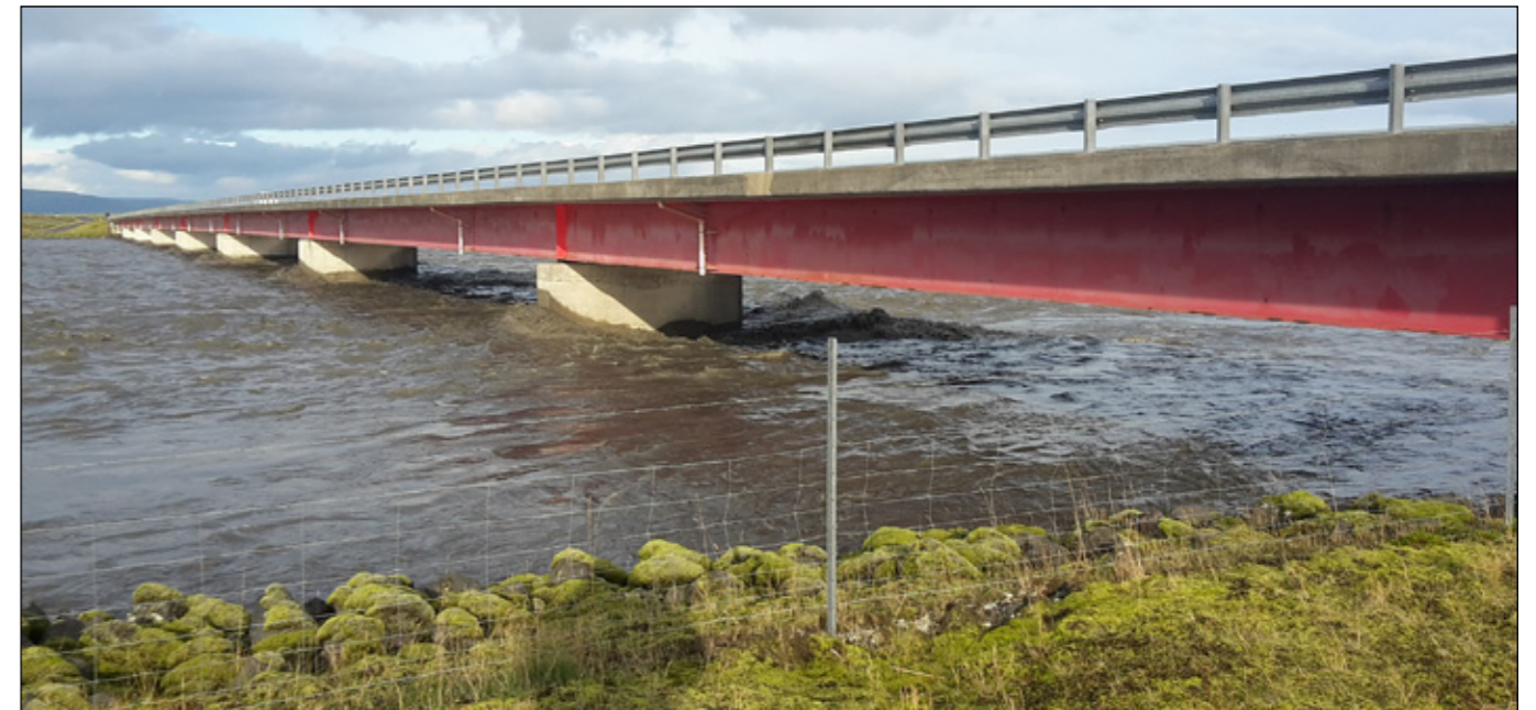
Brú yfir Kúdafljóti á Hringvegi (1) 2. október 2015 kl. 17:10. Það var víðar en í Eldvatni sem álag var á brýr í þessu Skaftárhlaupi.
