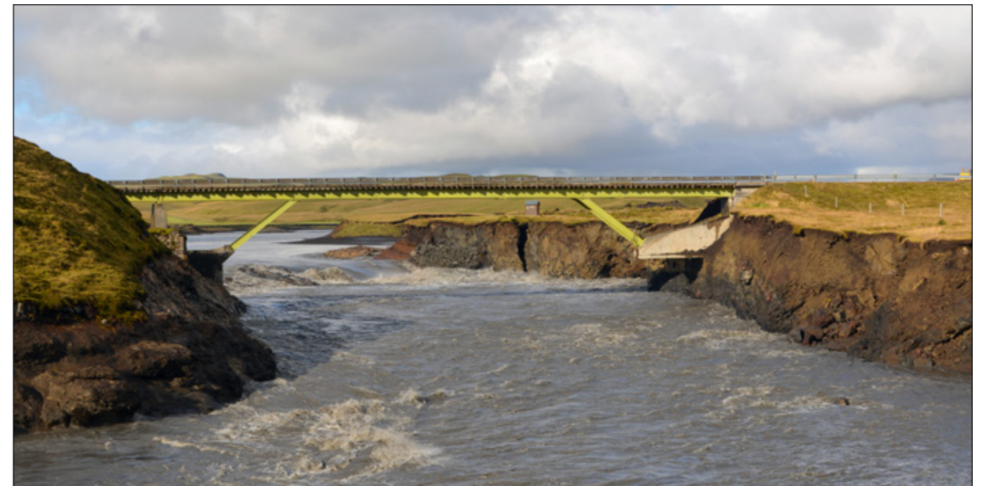
Þessar myndir af brúnni yfir Eldvatn hjá Ásum eru teknar úr sitthvorri áttinni en sýna vel rofið í austurbakkann sem er til vinstri á efri myndinni (27. ágúst 2013) en til hægri á neðri myndinni (8. október 2015). Austur stöpullinn hefur verið hannaður til að standa þótt það græfi undan útkröguninni en burðaröl brúarinnar er auðvitað mikið skert.
