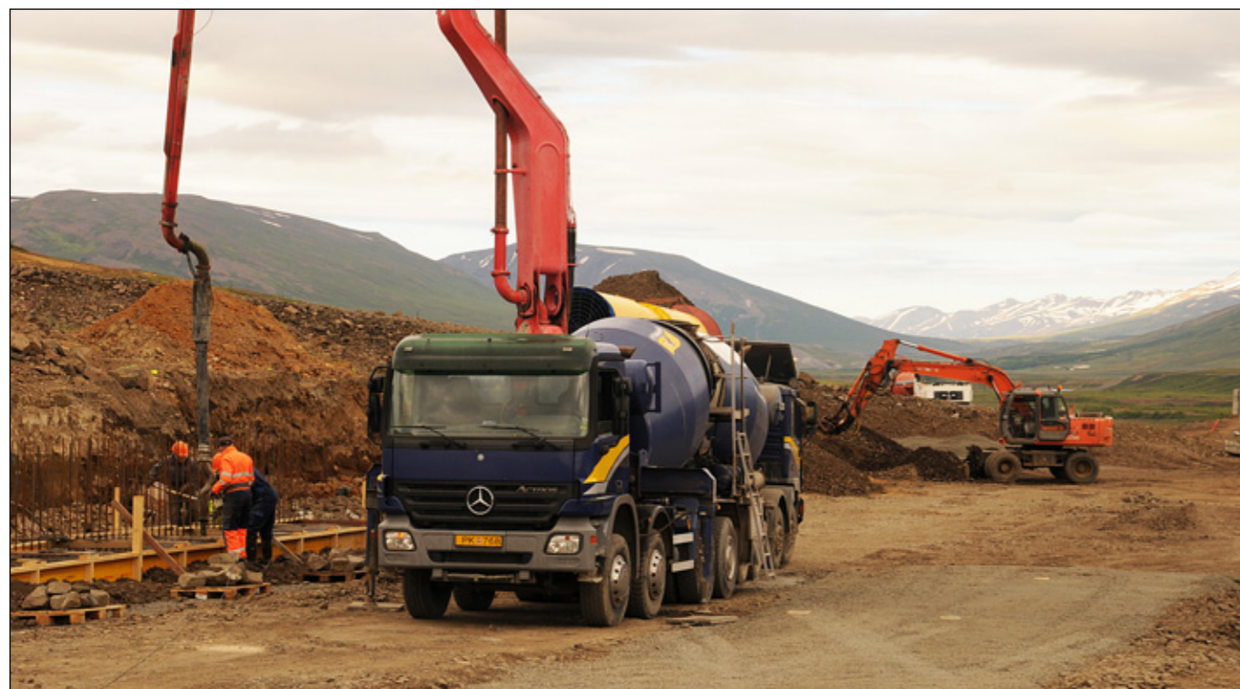
Vaðlaheiðargöng í Fnjóskadal. Unnið við undirstöður fyrir vegskála 18.08.2015.
