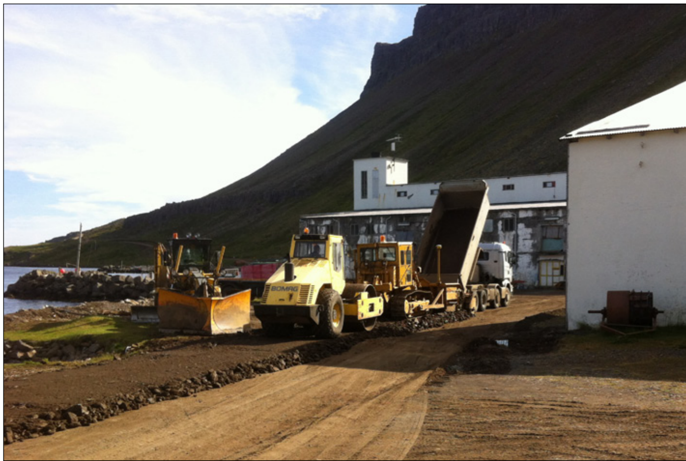
Burðarlag undir klæðingu lagt út á Djúpuvík sumarið 2015. Vegagerðin hefur í nokkurn tíma vitað af áætlunum Ísavia um að leggja bundið slitlag á flugvöllinn á Gjögri. Var talið eðlilegt og hagkvæmt að leggja slitlag á nokkra kafla í Árneshreppi samhliða flugvallarframkvæmdinni. Klæðingarefni og efra burðarlagsefni var unnið þar norðurfrá 2013 og lét Vegagerðin vinna efni fyrri sig í leiðinni. Flugvallarframkvæmdum var frestað þar til í sumar og var ákveðið að Vegagerðin fylgdi í kjölfarið. Tæknideild Vegagerðarinnar á Vestursvæði hafði umsjón með verkinu og samdi við þjónustustöð Vegagerðarinnar á Hólmavík um að verkstýra verkinu. Verktakinn (Borgarverk) á flugvellinum lagði klæðinguna. Verkið var fjármagnað af liðnum „bundið slitlag á tengivegi“. Lagt var á slitlag á fjórum stöðum, á Djúpuvík 210 m, við Finnbogastaði 1.200 m, við Mela 300 m og í Norðurfjarðarbotni að bryggju 1.020 m. Alls 2.730 m.
