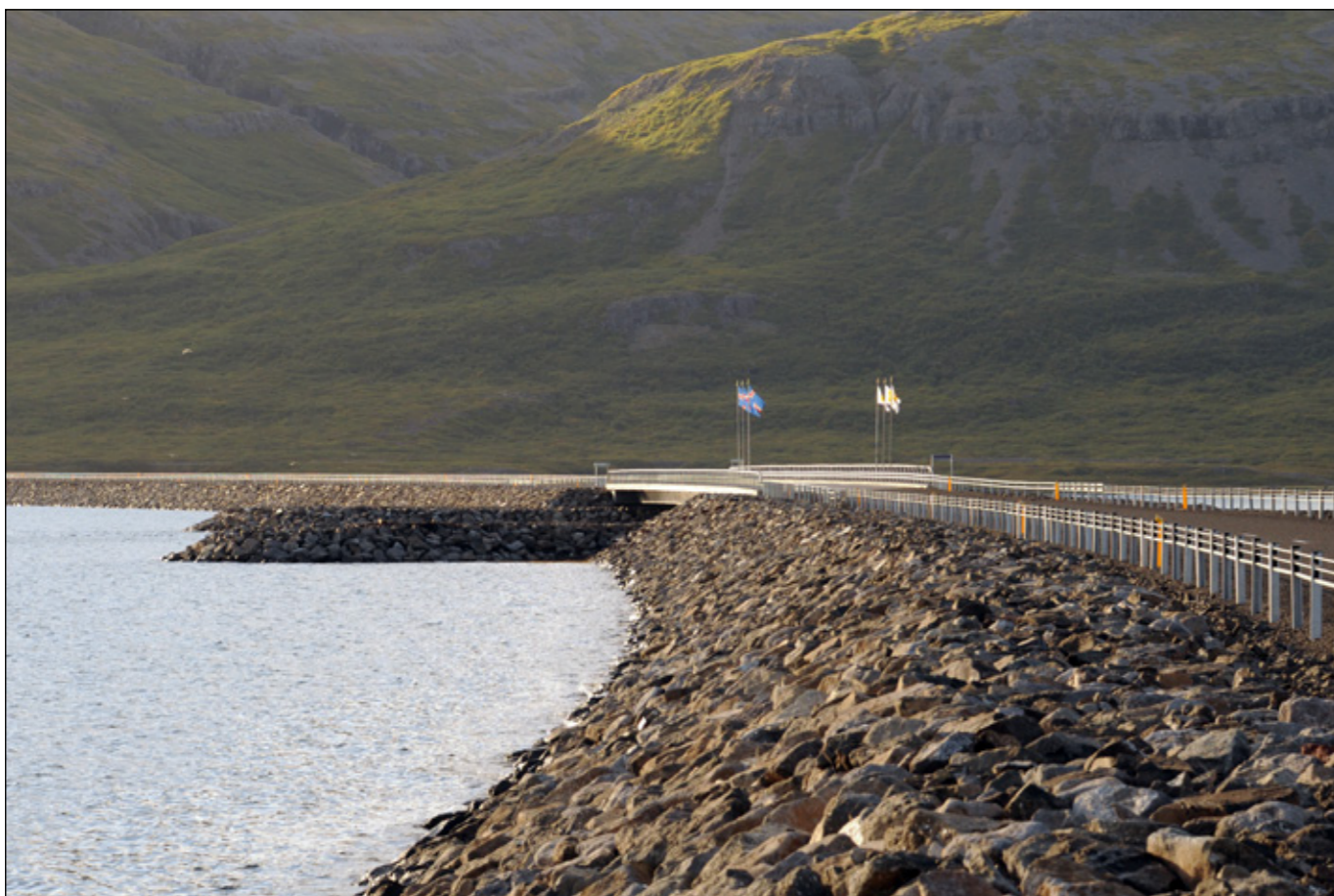
Vestfjarðavegur (60), Eiði - Þverá, vígsla föstudaginn 11. september 2015. Fylling og brú á Kjálkafirði á vígsludegi.
