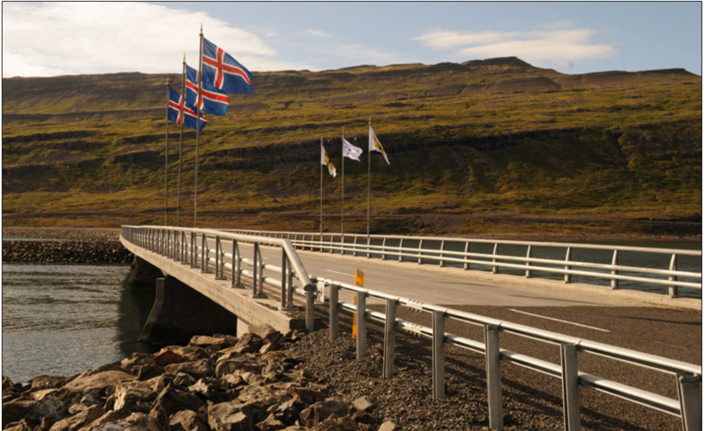
Vestfjarðavegur (60), Eiði - Þverá, vígsla föstudaginn 11. september 2015. Brú á Mjóafirði á vígsludegi.
