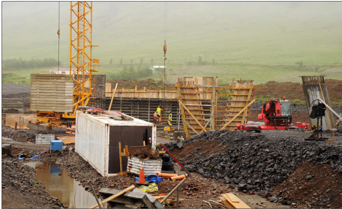
Eskifjarðará, brúargerð vegna tengingar við Norðfjarðargöng 20.08.2015.
