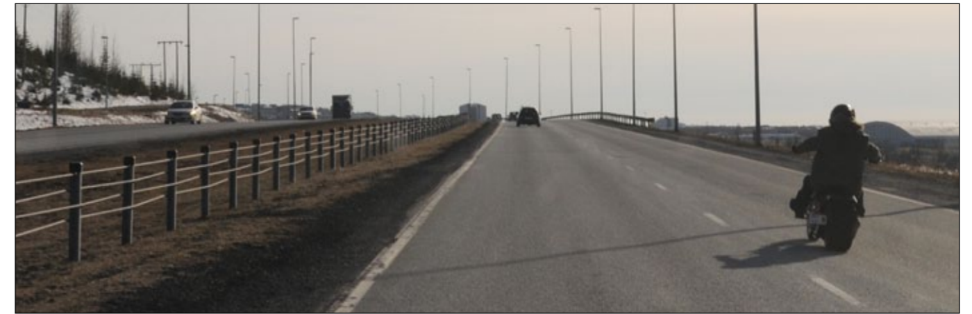
Vesturlandsvegur við Úlfarsfell
