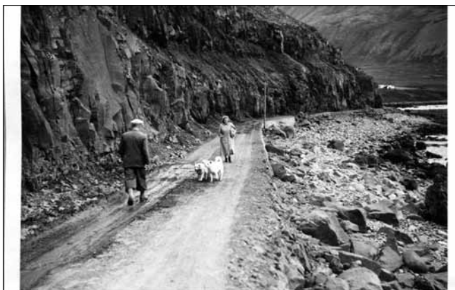
Suðureyrarvegur, undir Spilli
