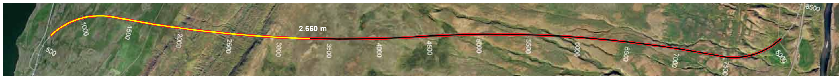
Vaðlaheiðargöng, staða framkvæmda 11. ágúst 2014. Búið er að sprengja 2.660 m frá Eyjafirði sem er 36,9% af heildarlengd.
