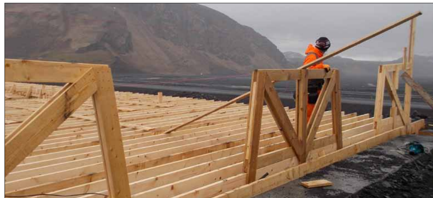
Uppsláttur undir brúardekk, 03.04.2014.
