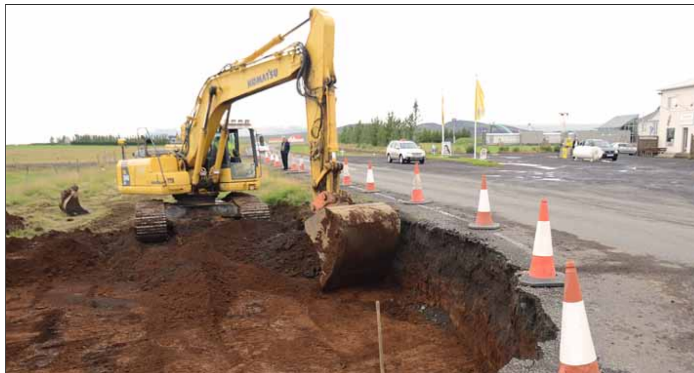
Unnið við nýtt hringtorg á Biskupstungnabraut (35) við Minni-Borg 15. ágúst 2012. Verktaki: Ræktunarsamband Flóa og Skeiða.
