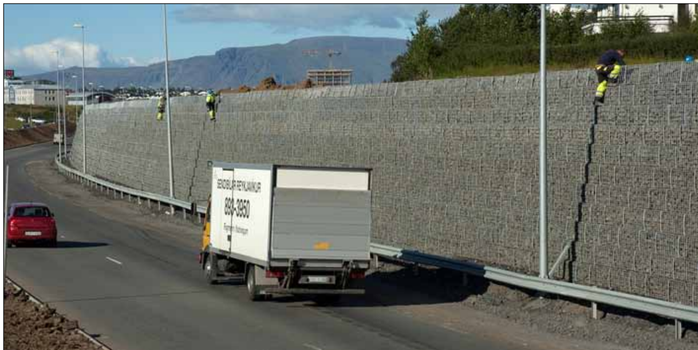
Lokafrágangur við hljóðmön við Reykjanesbraut í Garðabæ (gabions). Myndin er tekin í ágúst 2007.
