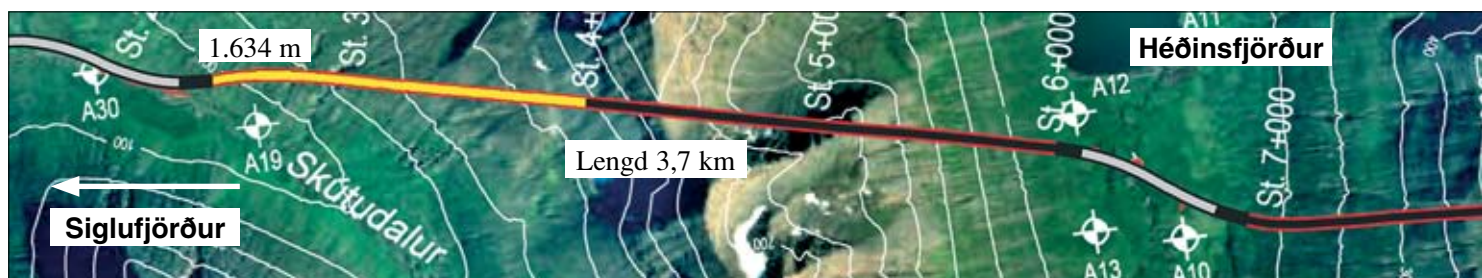
Staða framkvæmda við Héðinsfjarðargöng 15. maí 2007. Búið er að sprengja 1.634 m í Siglufirði og 1.160 m í Ólafsfirði.
