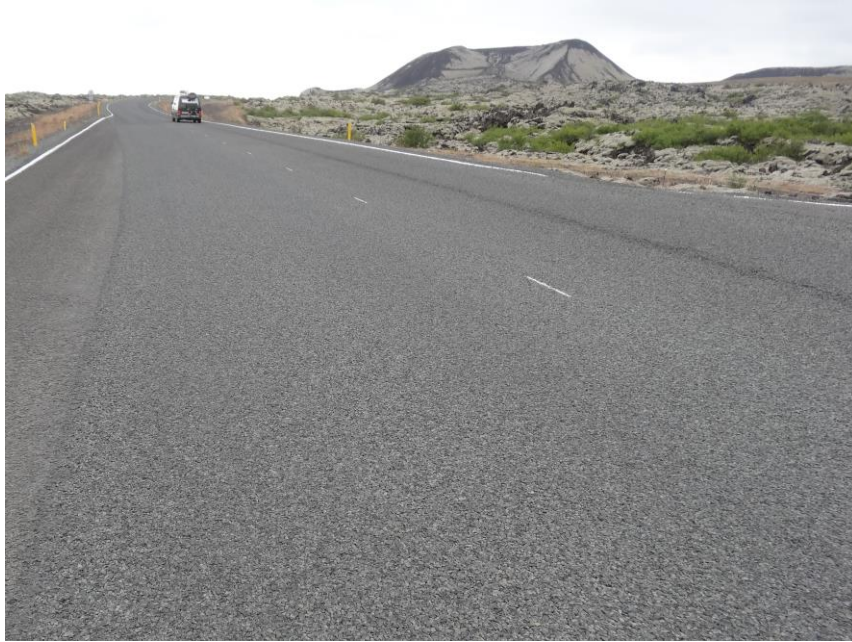
Mynd 31 Þjálbik/þunnbik með 3% etylester og 3% steinolú 2016
