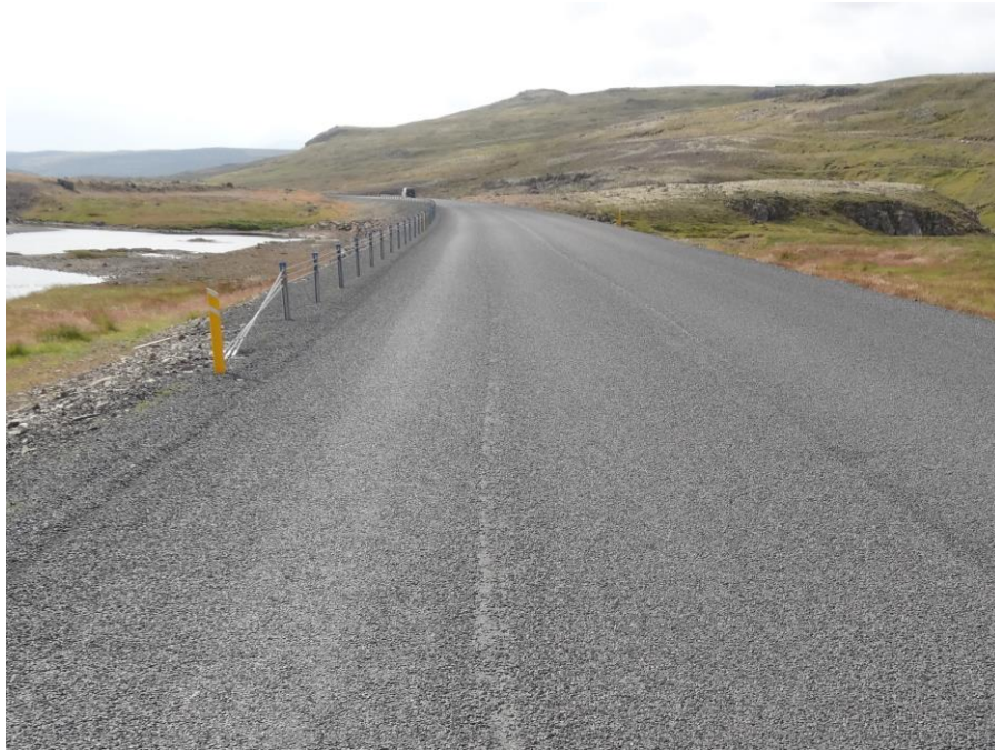
Mynd 43 Bikþeyta með TNB emulgator og án SBS 2016
