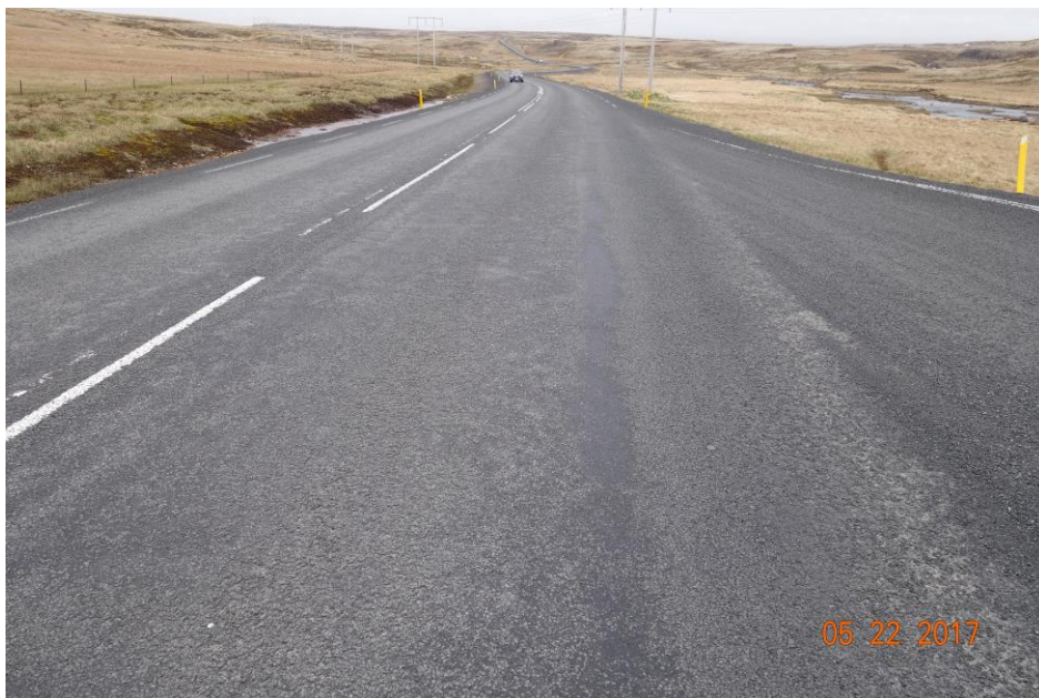
Mynd 56 Bikþeyta með R11 elmugator og með SBS í maí 2017
