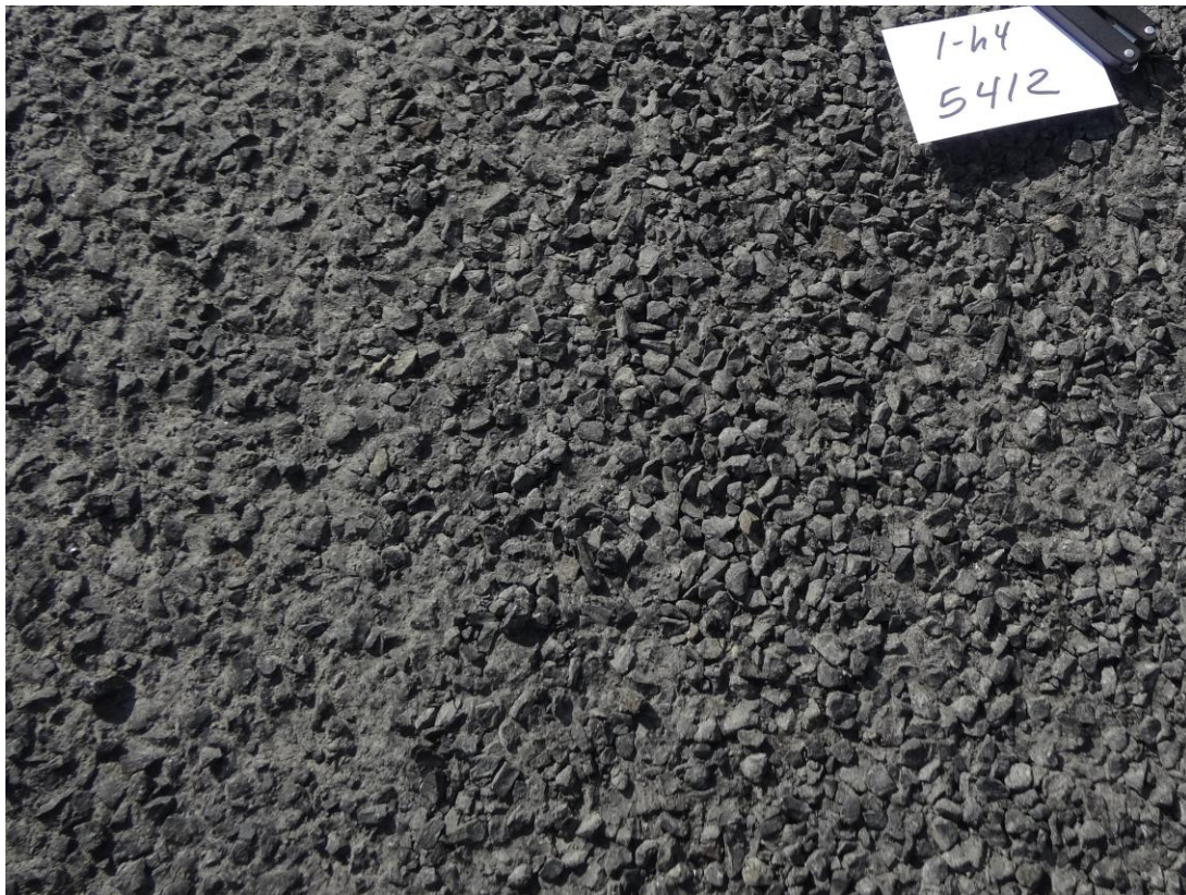
Mynd 54 Bikþeyta með R11 elmugator og með SBS 2016
