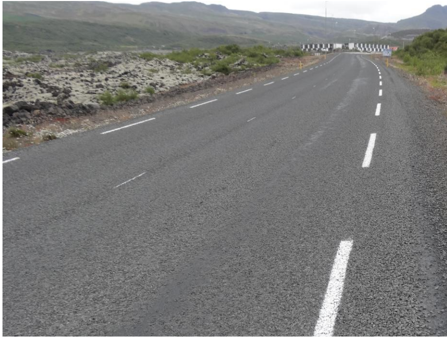
Mynd 25 Bikþeyta með R11 emulgator og SBS 2% 2016
