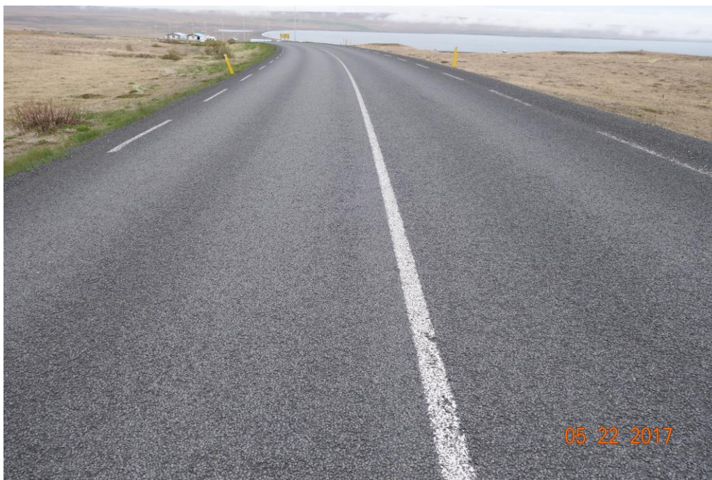
Mynd 59 Kafli á 1-k5 með 2,1 l/m 2 bikþeyta með latex í maí 2017
