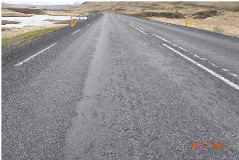
Mynd 44 Bikþeyta með TNB emulgator og án SBS í maí 2017
