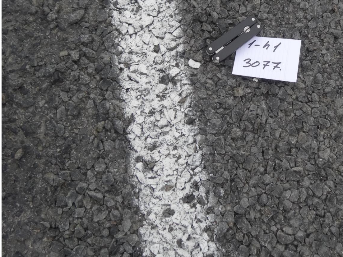
Mynd 21 Bikþeyta með TNB emulgator og SBS 2% 2016
