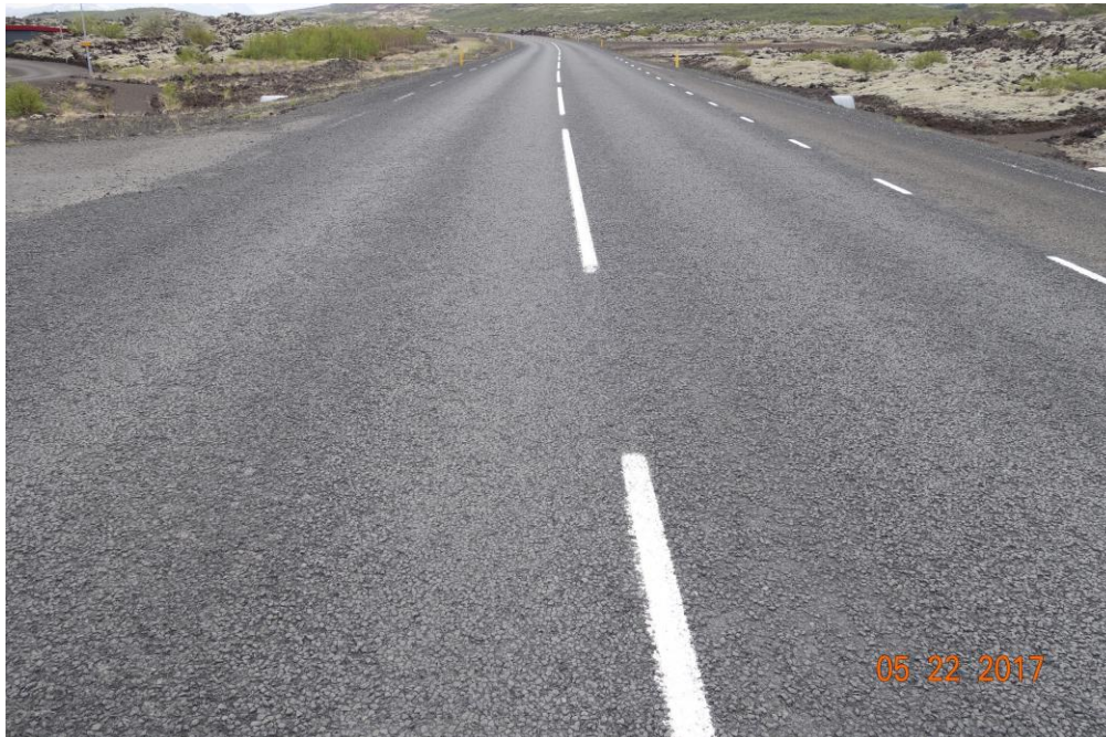
Mynd 23 Bikþeyta með TNB emulgator og SBS 2% í maí 2017
