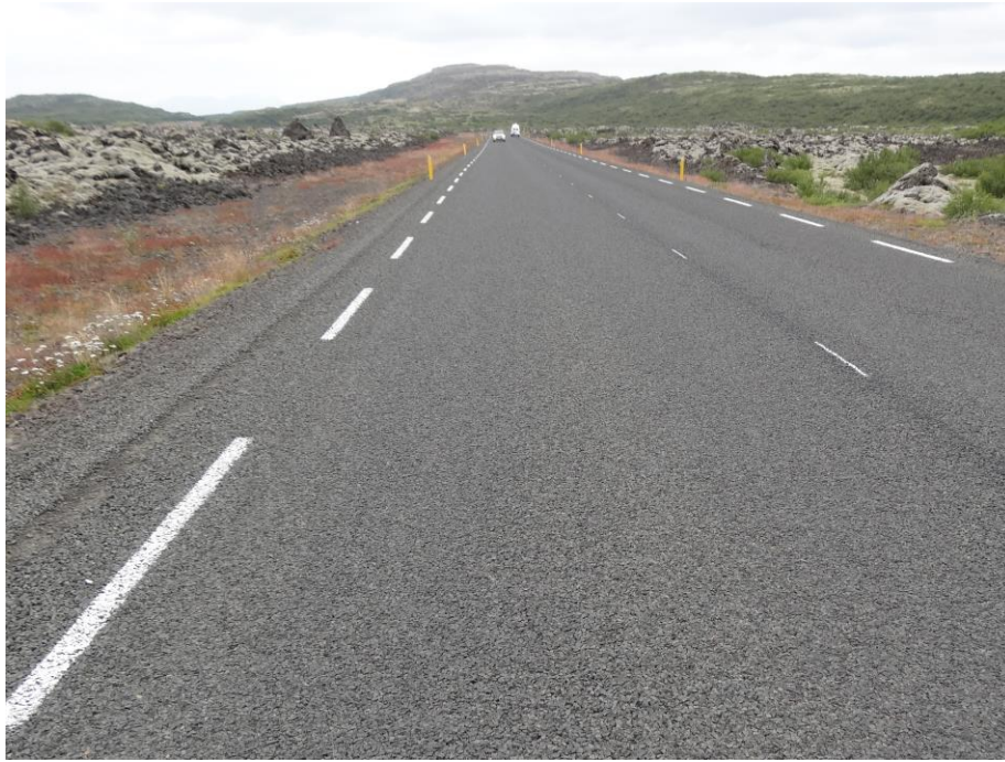
Mynd 16 Bikþeyta með R11 emulgator og bikþeytan án latex 2016
