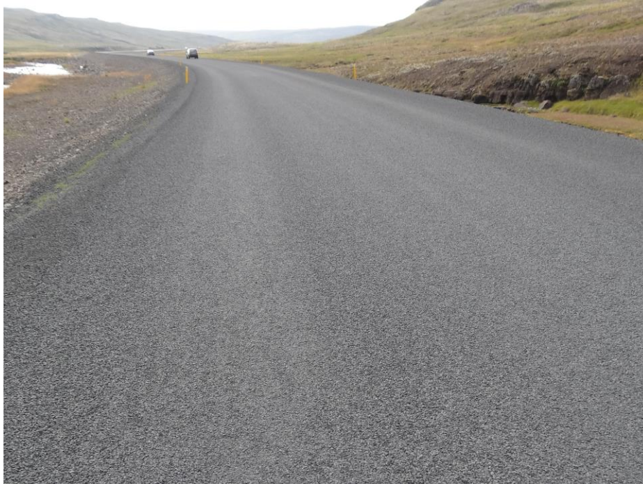
Mynd 40 Þjálbik/þunnbik með 3% etylester og 3% steinolú 2016
