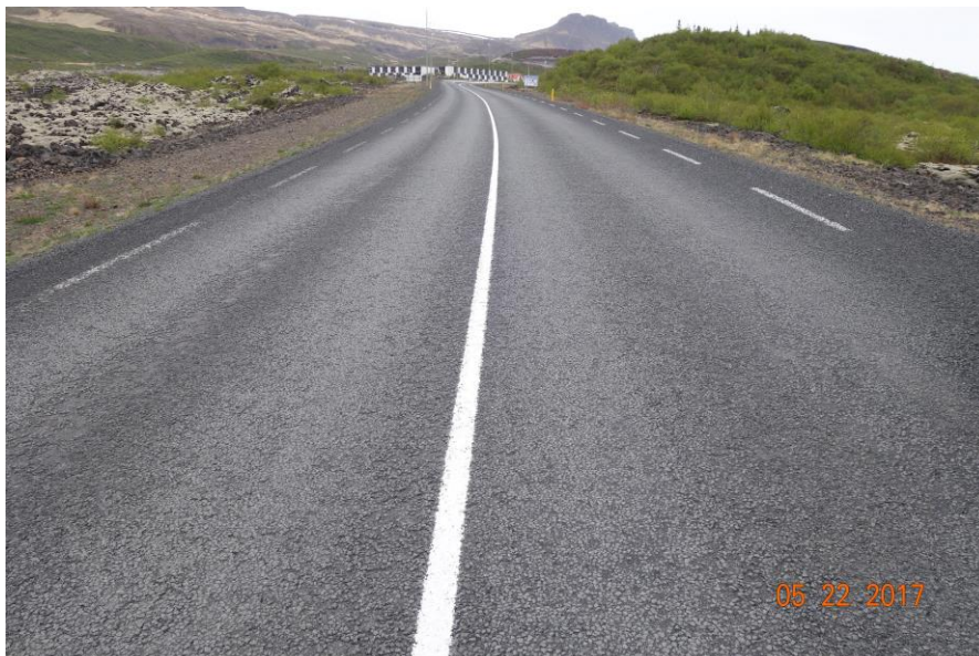
Mynd 26 Bikþeyta með R11 emulgator og SBS 2% í maí 2017
