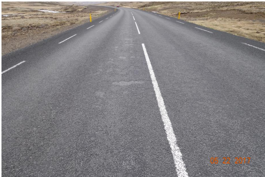
Mynd 53 Bikþeyta með TNB emulgator og með SBS í maí 2017
