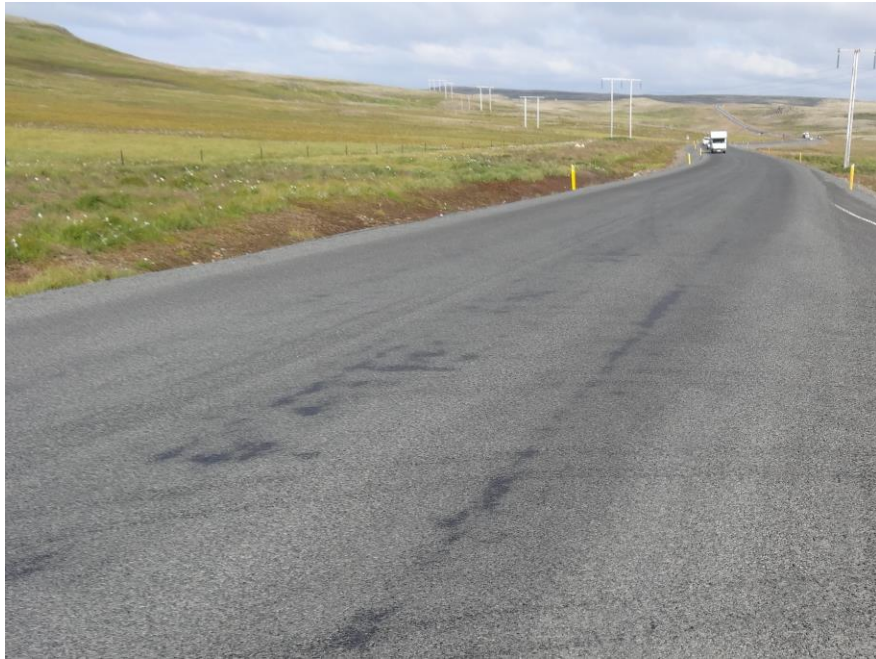
Mynd 55 Bikþeyta með R11 elmugator og með SBS 2016
