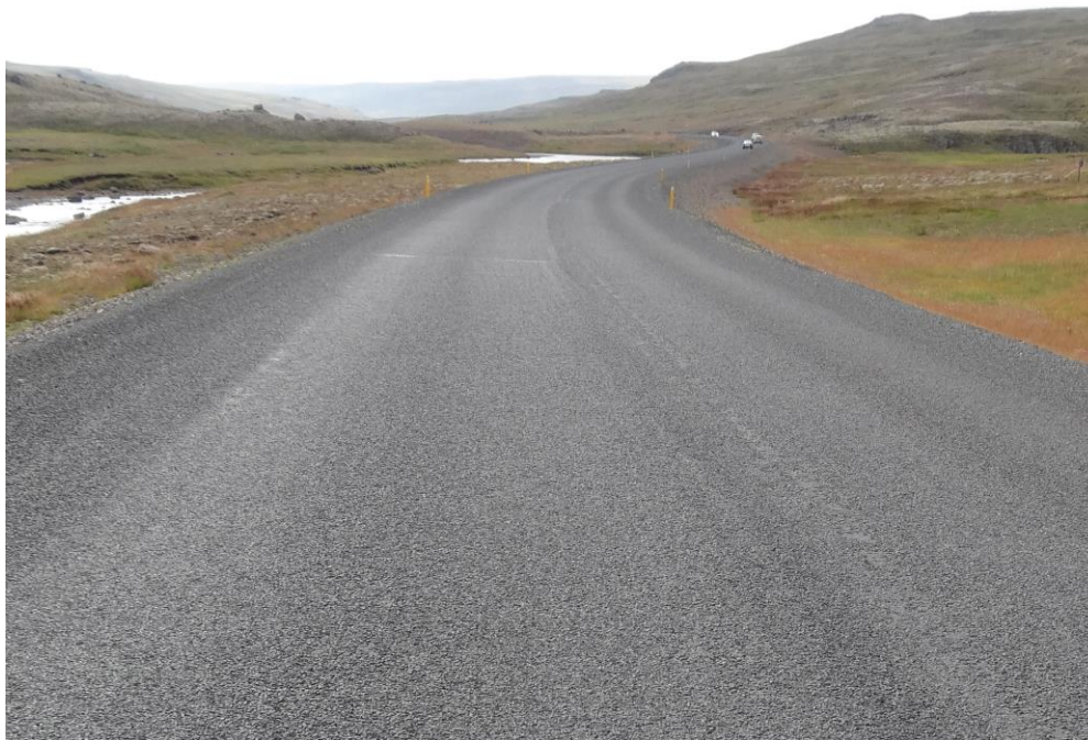
Mynd 46 Bikþeyta með R11 elmugator og án latex 2016
