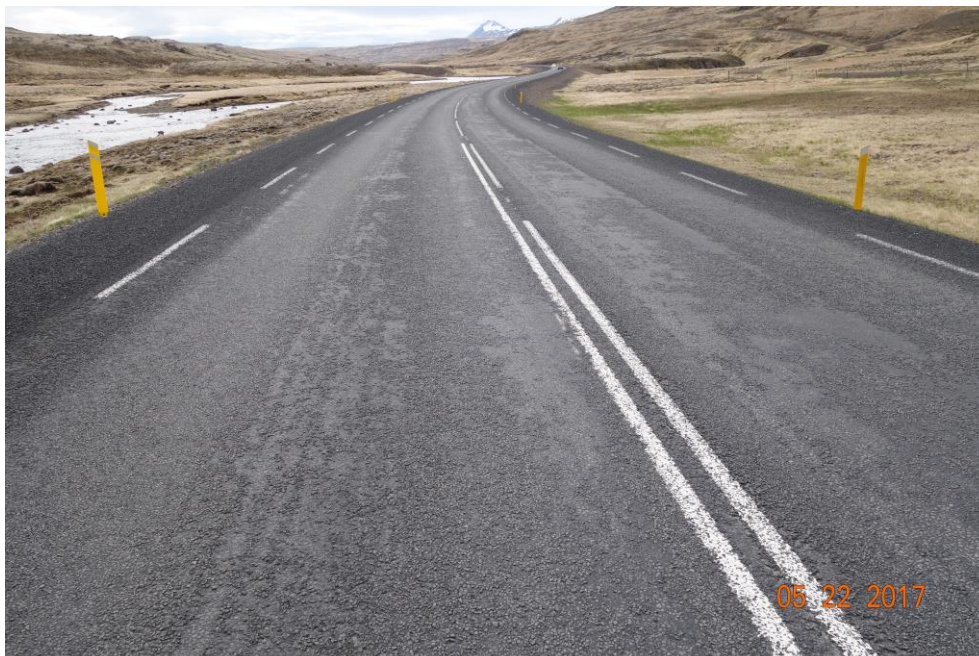
Mynd 47 Bikþeyta með R11 elmugator og án latex í maí 2017
