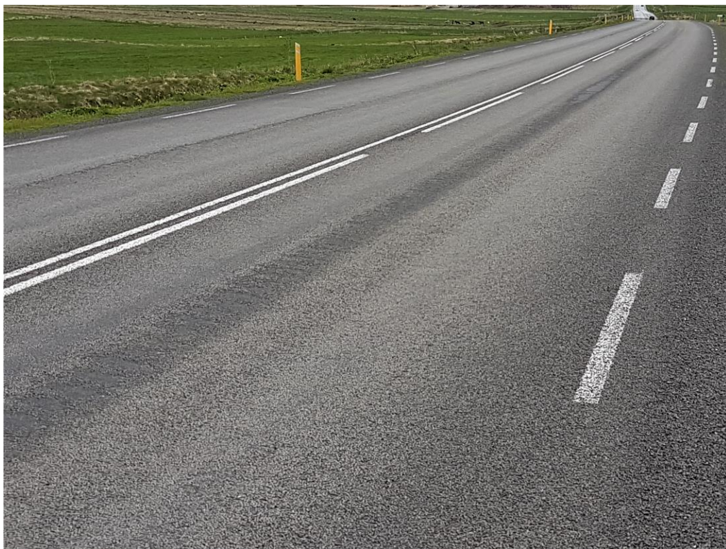
Mynd 84 Kafli á 1-p6 bikþeyta án latex í maí 2017 í stöð 835, plógskemmdir
