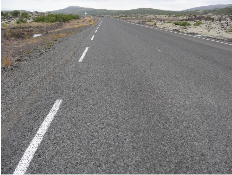
Mynd 22 Bikþeyta með TNB emulgator og SBS 2% 2016
