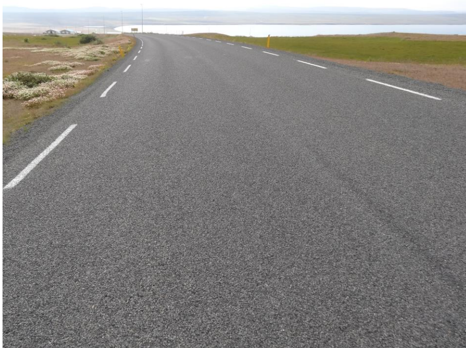
Mynd 58 Kafli á 1-k5 með 2,1 l/m 2 bikþeyta með latex frá 2016
