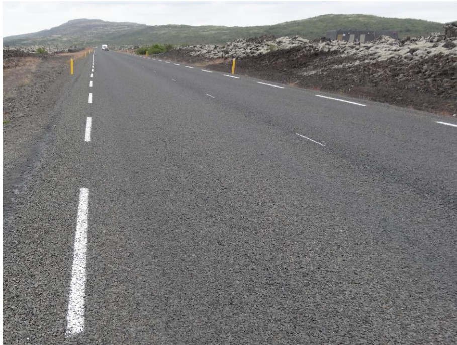
Mynd 19 Bikþeyta með R11 emulgator og bikþeytan með latex (SBR 2%) 2016
