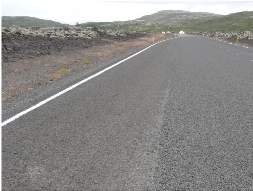
Mynd 13 Bikþeyta með TNB emulgator og án SBS 2016
