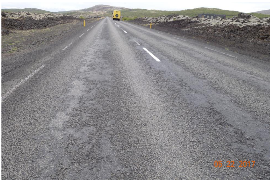
Mynd 20 Bikþeyta með R11 emulgator og latex (SBR 2%) í maí 2017
