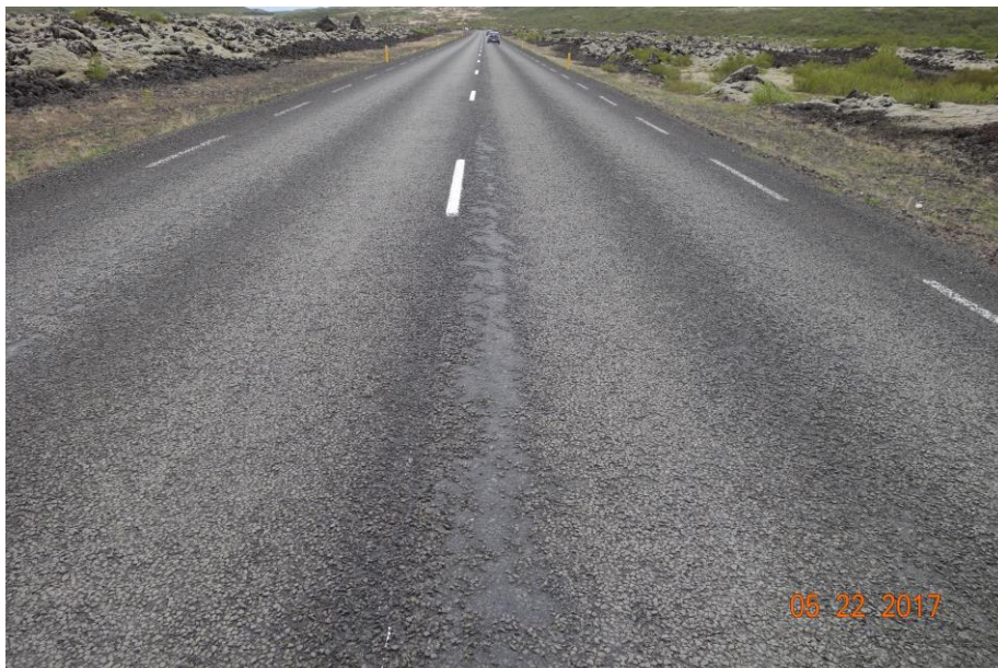
Mynd 17 Bikþeyta með R11 emulgator og bikþeytan án latex í maí 2017
