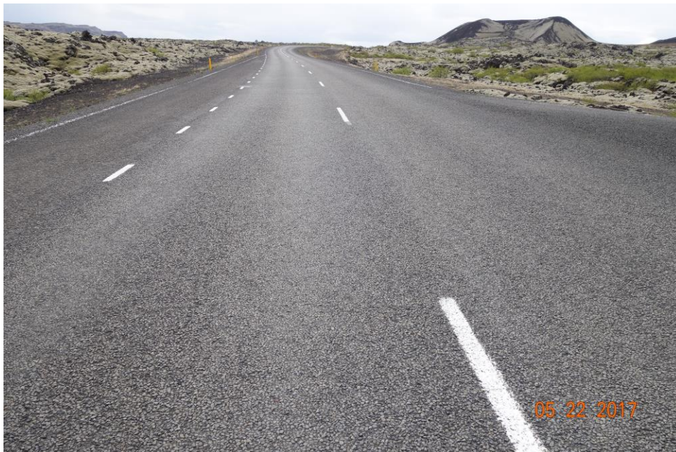
Mynd 32 Þjálbik/þunnbik með 3% etylester og 3% steinolú í maí 2017
