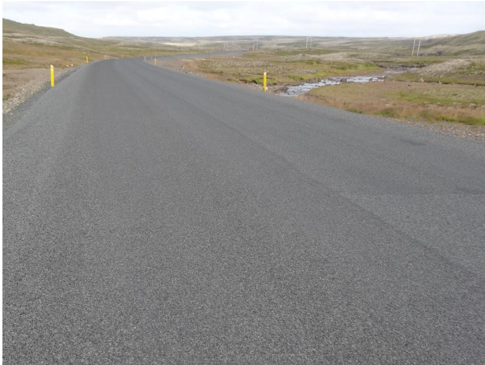
Mynd 49 Bikþeyta með R11 elmugator og með latex 2016
