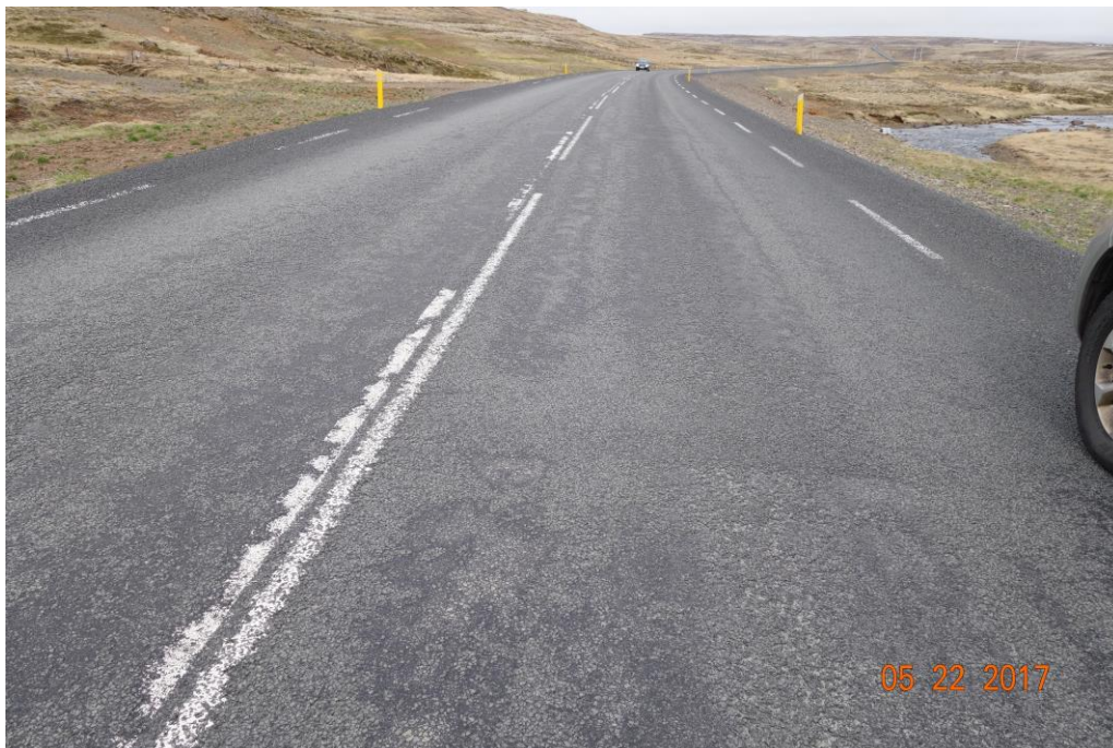
Mynd 50 Bikþeyta með R11 elmugator og með latex í maí 2017
