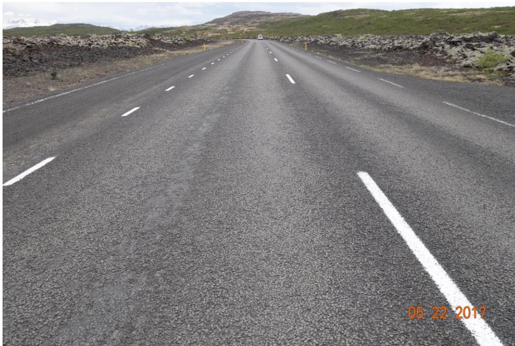
Mynd 14 Bikþeyta með TNB emulgator og án SBS, úttekt í maí 2017
