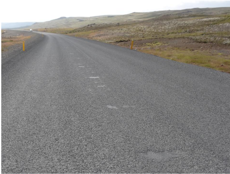
Mynd 52 Bikþeyta með TNB emulgator og með SBS 2016
