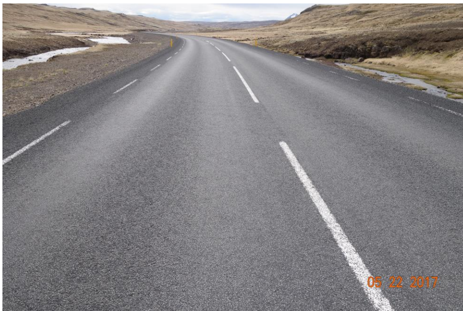
Mynd 41 Þjálbik/þunnbik með 3% etylester og 3% steinolú í maí 2017
