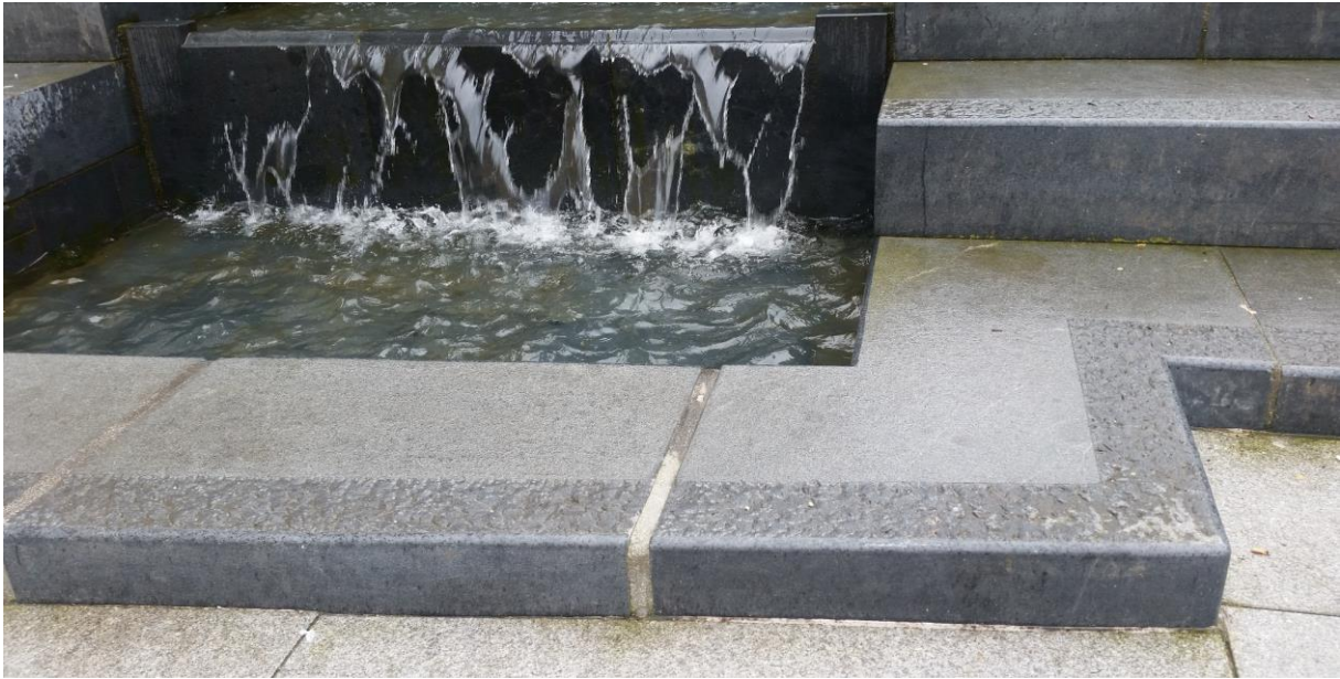
Mynd 4-17 Á myndinni er merking á tröppubrún gefin til kynna með mun á áferð og um leið litamun. Skýrari litamunur kemur upplýsingum um hæðarmun betur til skila til sjóndapra. . (Mynd: Áslaug Katrín Aðalsteinsdóttir)
