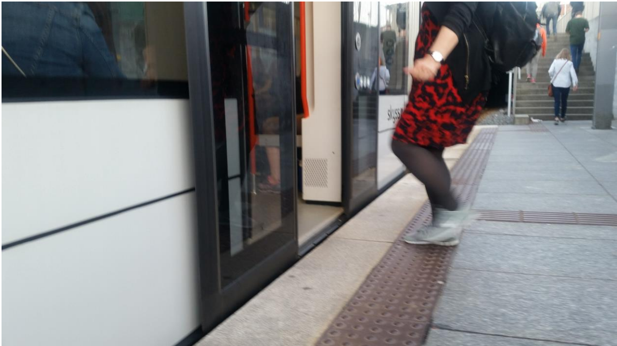
Mynd 5-1 Þægilegt aðgengi frá biðstöð rakteitt inn í vagninn, búið er að hækka kantstein hér. (Mynd: Áslaug Katrín Aðalsteinsdóttir)
