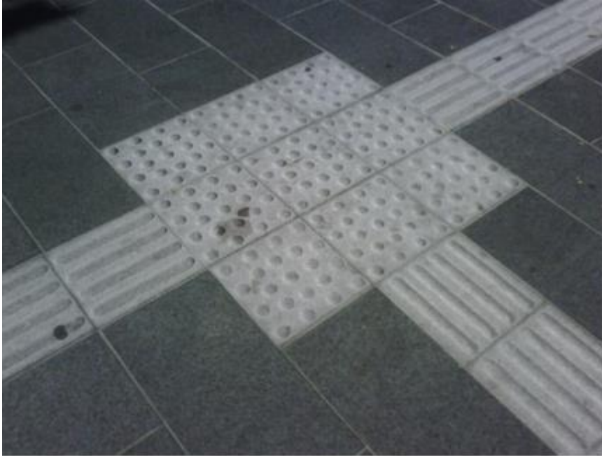
Mynd 4-10 Dæmi um danska hönnun þar sem stefnubreyting er gefin til kynna með 90x90cm svæði með áherslu-/varúðarflötum ((Pedersen et al., 2013 bls. 58)
