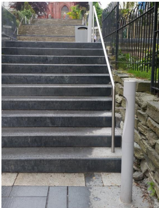
Mynd 4-18 Hér má sjá ólík áhrif þar sem annars vegar eru tröppur án merkinga og handrið er með einföldum handlista og hins vegar þar sem búið er að teikna merkingar á tröppubrún, lengja handrið og bæta við handlista. (Mynd: Áslaug Katrín Aðalsteinsdóttir)
