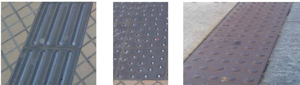
Mynd 4-5 Leiðarlínur, stefnuvísir (til vinstri) og áherslu-/varúðarflötu (í miðju og til hægri) algengt er að einungar séu úr steypu, graníti eða steypujárni. Einnig eru til hnappar og línur úr málm og eru þær límdar/festar við yfirborðsefni bæði innan og utanhúss. (Myndir: Áslaug Katrín Aðalsteinsdóttir)
