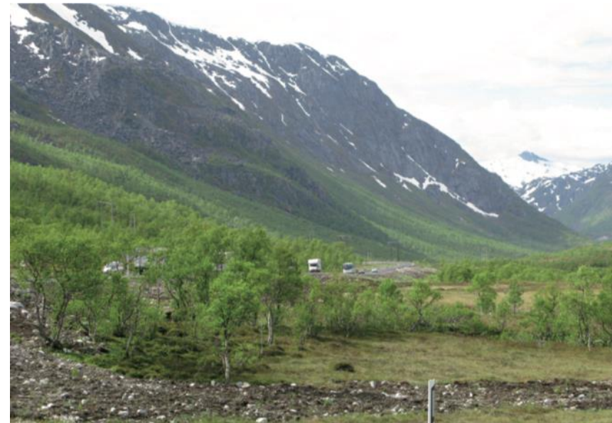
Mynd 16. Við gerð vegar E10 í Lofoten, Noregi var haldið í einstaka skógarrjóður til að fella veginn betur inn í landslagið og skapa fjölbreytni í vegfláanum. Mynd: Vegdirektoratet, 2009.
