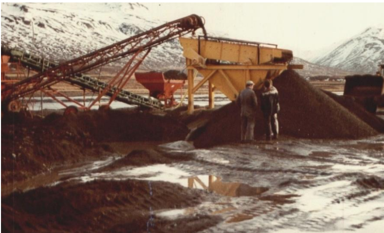
Mynd 6.2.2.11. Malarvinnslan að þvo efri hluta burðarlags með þvottahörpu í Grímsá í Skriðdal (Hilmar Finnsson 1983).
