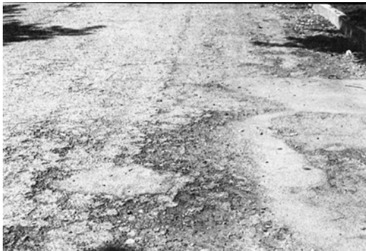
Mynd 4.13: Steintap í malbiki. [Ljósmynd: The Asphalt Institute 1983]
