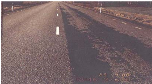
Mynd 4.18: Slit á klæðingu, steinlos.
