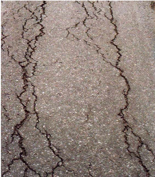
Mynd 4.5: Langsprungur, lélegt burðarlag og frostlyfting.
