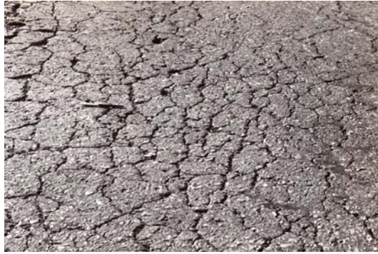
Mynd 4.9: Smáger sprungunet, veikleiki í efra burðarlagi.
