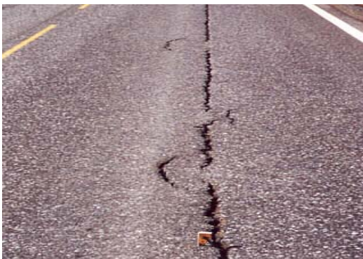
Mynd 4.6: Langsprungur vegna breikkunar.
