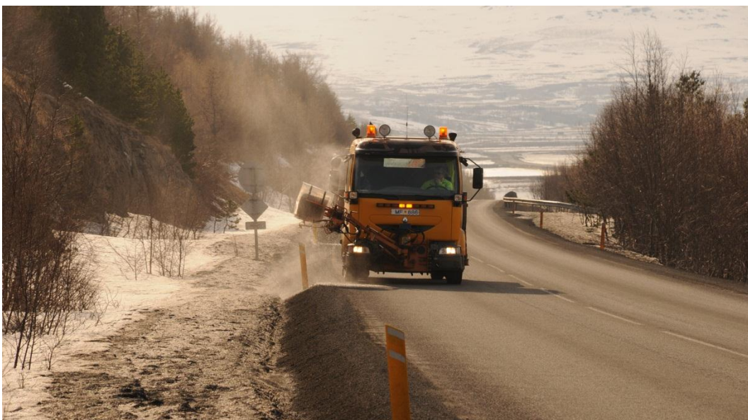
Mynd 25. Hreinsun á vegstikum á Hringvegnum austan Akureyrar (VAI).
