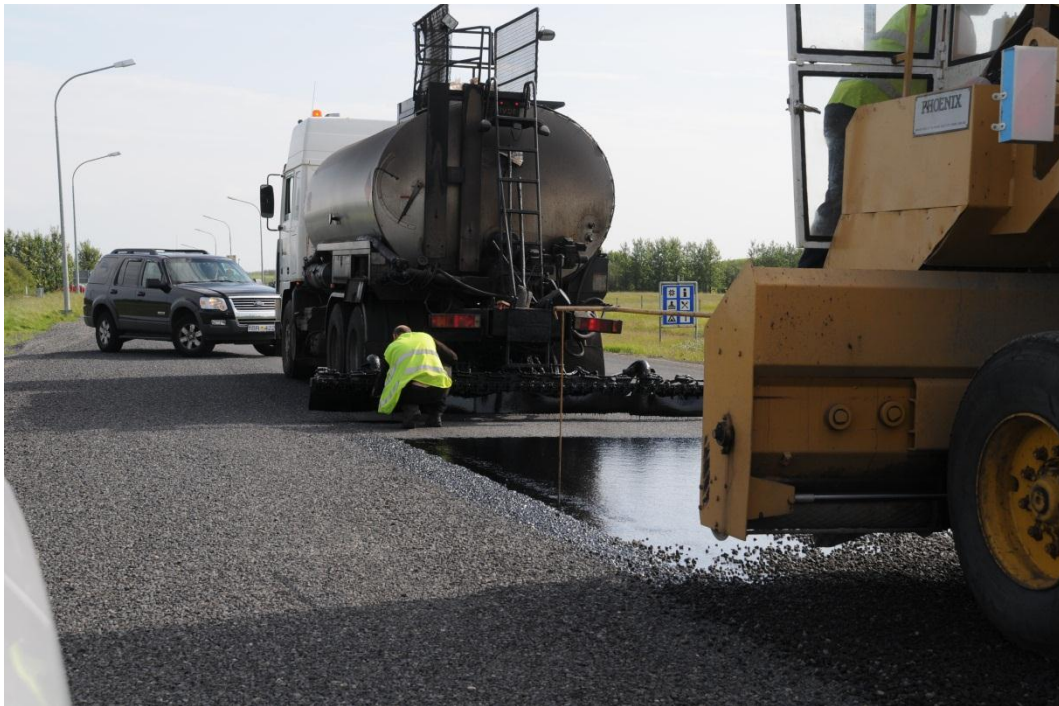
Mynd 23. Asfalt dreifari á Hringveginum vestan við Hellu (VAI).
