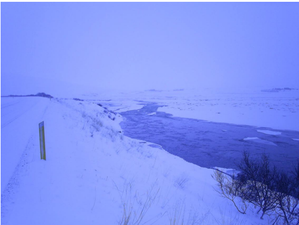
Mynd 47. Hringvegur 1-h2 í Norðurárdal. Hér hefur Norðurá lagst upp að hringveginum vegna klakastíflu í aðalfarveginum. Venjulega er lítið rennsli þarna meðfram veginum en ljóst að hér vantar vegrið. (Valgeir Ingólfsson).
