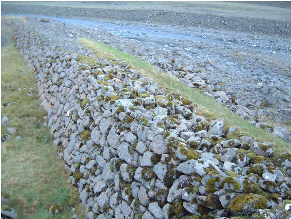
Mynd 7. Gamall varnargarður við Grjótá í Hornafirði. EFJ.
