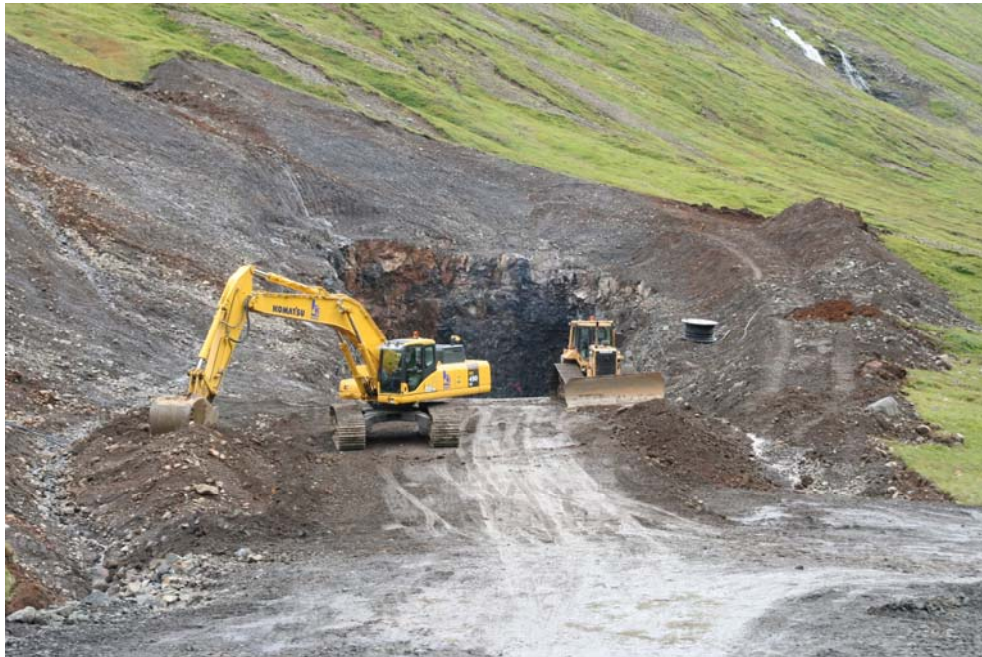
Mynd 11. Vinna við Hédiðsfjarðargöng Siglufjarðarmegin, haustið 2006. VK.
