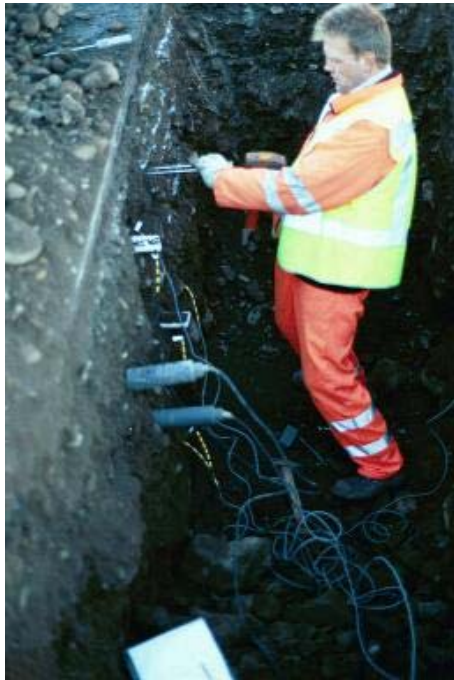
M7 Unnið við að koma mælum fyrir.
