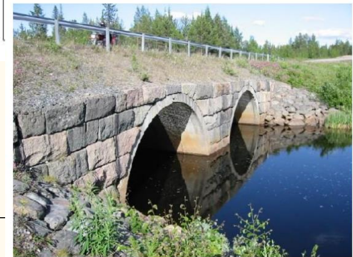
Bridge over Liukattijoki 4 km NW Svappavaara on Road E10
