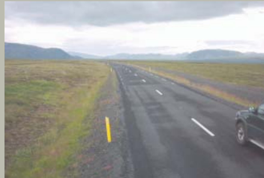
Mynd 15. Vegur yfir Mosfellsheiði - sambærilegur Suðurstrandarvegi
