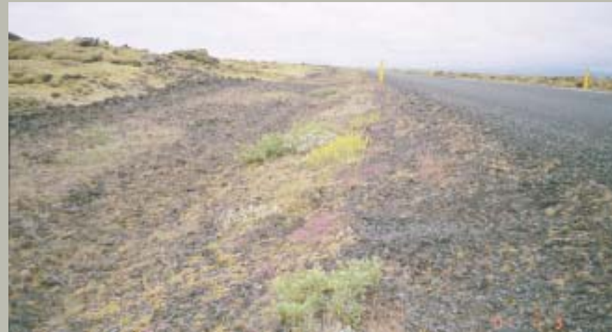
Mynd 25. Dæmi um góðan frágang vegfláa í hrauni - Eldhraun í Landbroti
