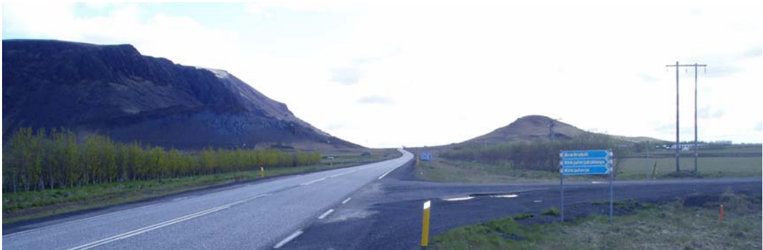
Mynd 2-6 Horft austur frá Kirkjuferjuvegi (3915) að staðsetningu fyrirhugaðra mislægra vegamóta við Hvammsveg eystri (374). Ingólfsfjall og Kögunarhóll sjást í baksýn.
