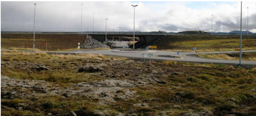
Mynd 4-21 Vegamót í Hvassahrauni eru að svipaðri gerð og vegamótin verða á fjórum stöðum á Suðurlandsvegi.
