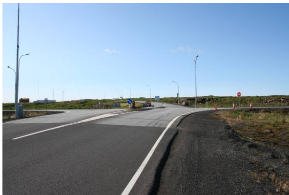
Horft til suðurs
