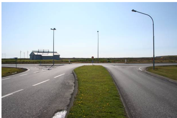
Horft til suðurs
