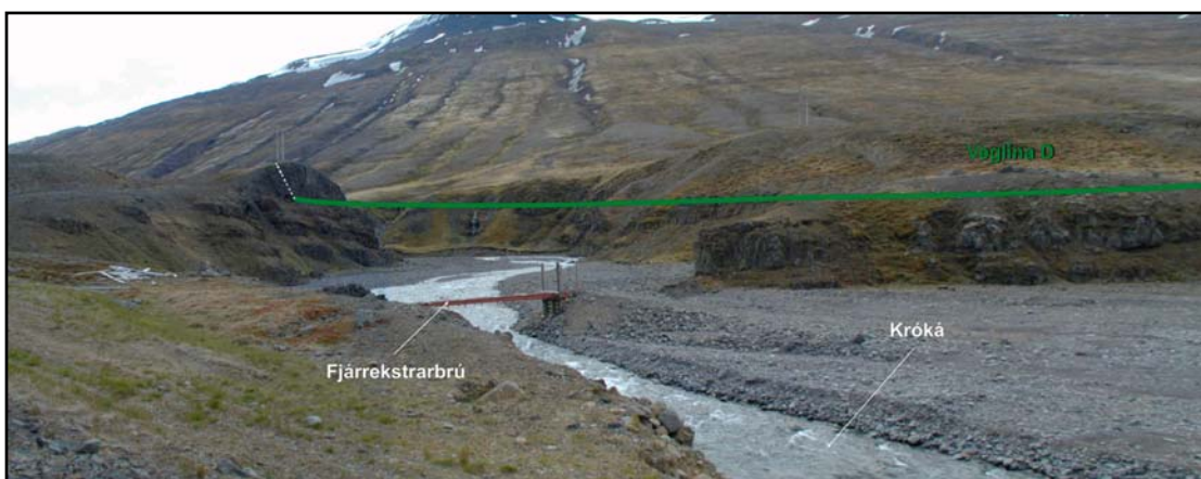
Mynd 9. Austan Krókár af núverandi vegfyllingu. Veglína D stefnir þvert yfir Krókárgilið í stefnu á staurastæðu Byggðalínunnar á gilbarminum. Djúp klapparskering verður til austurs meðfram Krókárgili.
