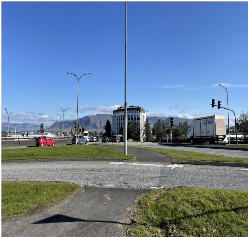
Mynd 16 dæmi um skert útsýni vegna ljósastaura. Vesturlandsvegur - Höfðabakki
