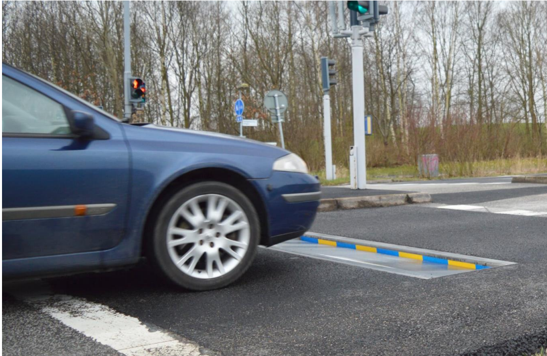
MYND 10 Gagnvirk hraðahindrun. Ef ekið er yfir leyfilegum hámarkshraða fellur hleri niður (Actibump, 2022)
