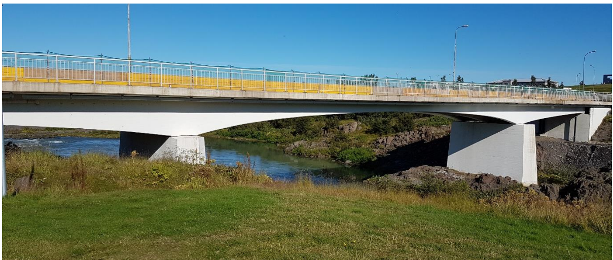
MYND 2 Brú á Blöndu. Fyrsta eftirspannta brúin á Íslandi, byggð 1963.
