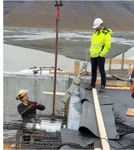
MYND 17 Hitamælar við akkeri í brú yfir Steinavötn. Til hægri er verið að spenna brúna. Einangrunarmottur á yfirborði.
