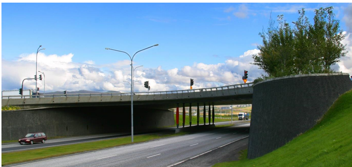
MYND 3 Brú á Höfðabakka. Eftirspennt brú byggð 1996.
