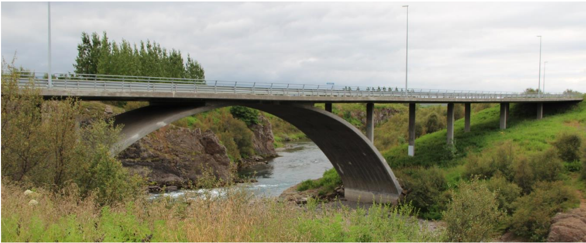
MYND 5 Brú á Eyvindará. Bogabrá með eftirspennta yfirbyggingu, byggð 2001.
