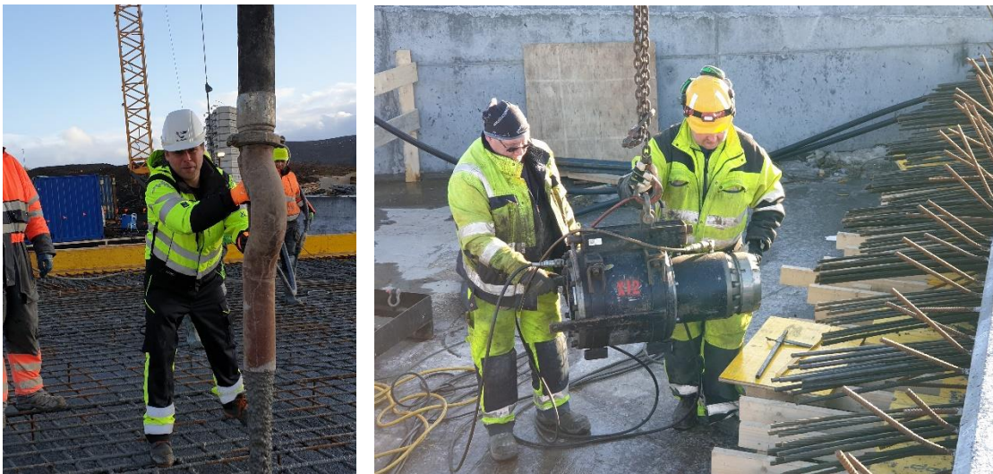
MYND 16 Brúin yfir Strandgötu steipt og spenn. Ólafur Sveinn pósar á steypudælnni.
