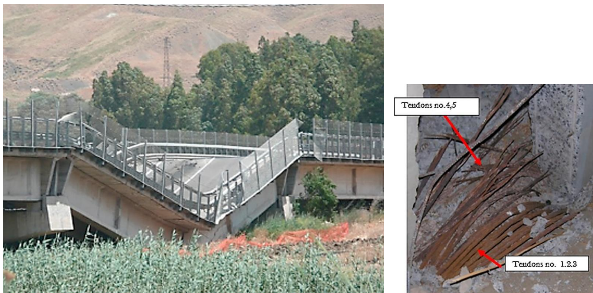
MYND 9 Petrulla landbrú (viaduct) á Sikiley, byggð 1985. Hrundi 2014. Til hægri eru tærðir kaplar. 3
