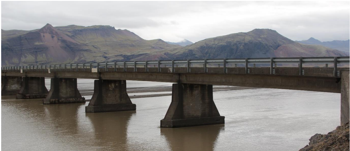
MYND 1 Brú á Hornafjarðarfljóti. Brú með forspanntum bitum, byggð 1960-61.
