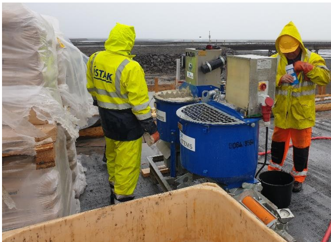
MYND 18 Grautað í kapla brúar yfir Steinavötn. Flæðipróf með trekt gert til hægri.
