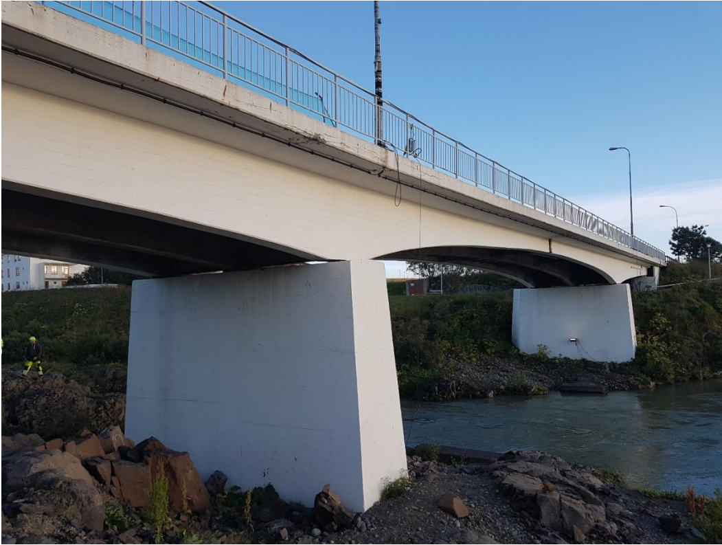
MYND 11 Brú á Blöndu, fyrsta eftirspennta brú á Íslandi, byggð 1963.
