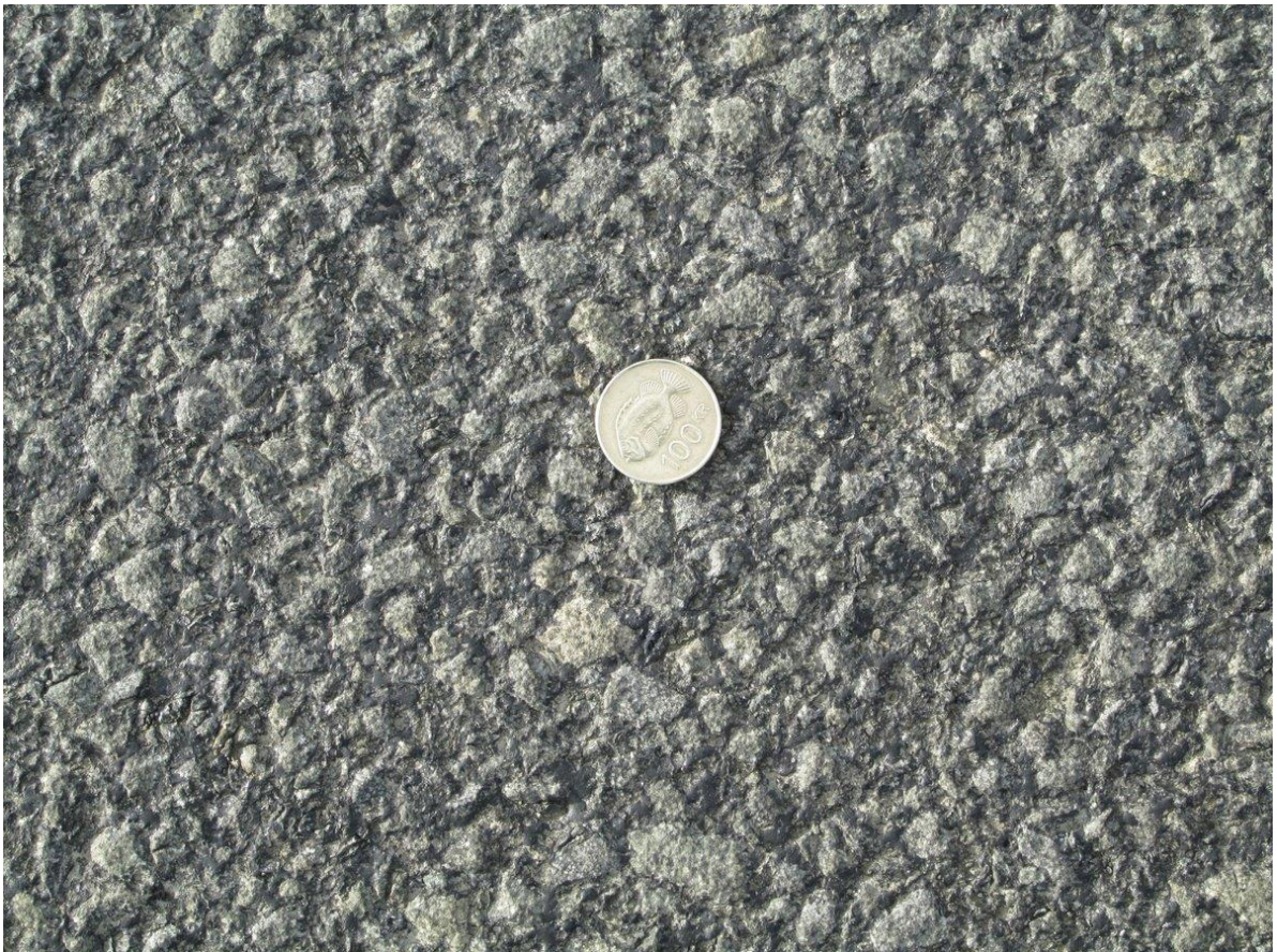
Mynd 211 er af metylesterkafla lagt 2013 þ.e. st. 8.910- 11.120
