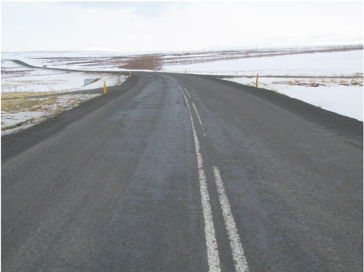
Mynd 2015 er tekin í byrjun kafla 85-04 og horft í vaxandi stöðvarstefnu. Á þeim kafla er lýsi sem mýkingarefni
