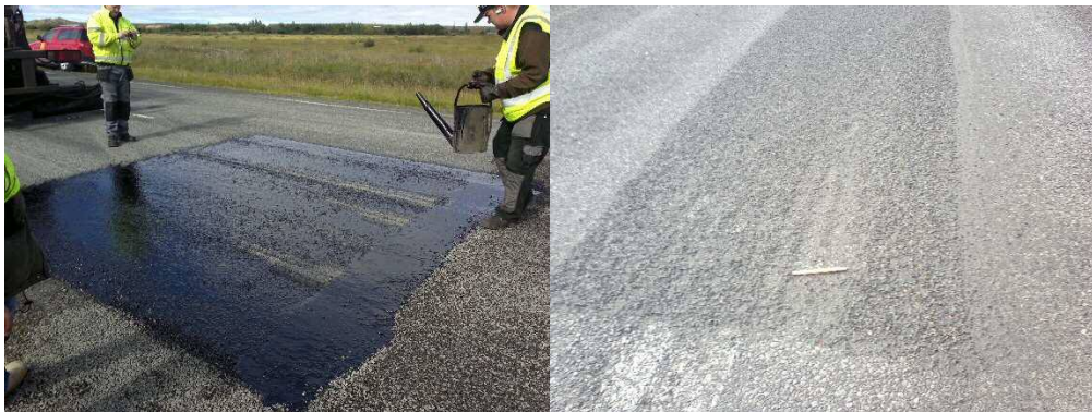
Mynd 9 Afleiðingar spíssa sem koma seinir inn eða eru klofnir
