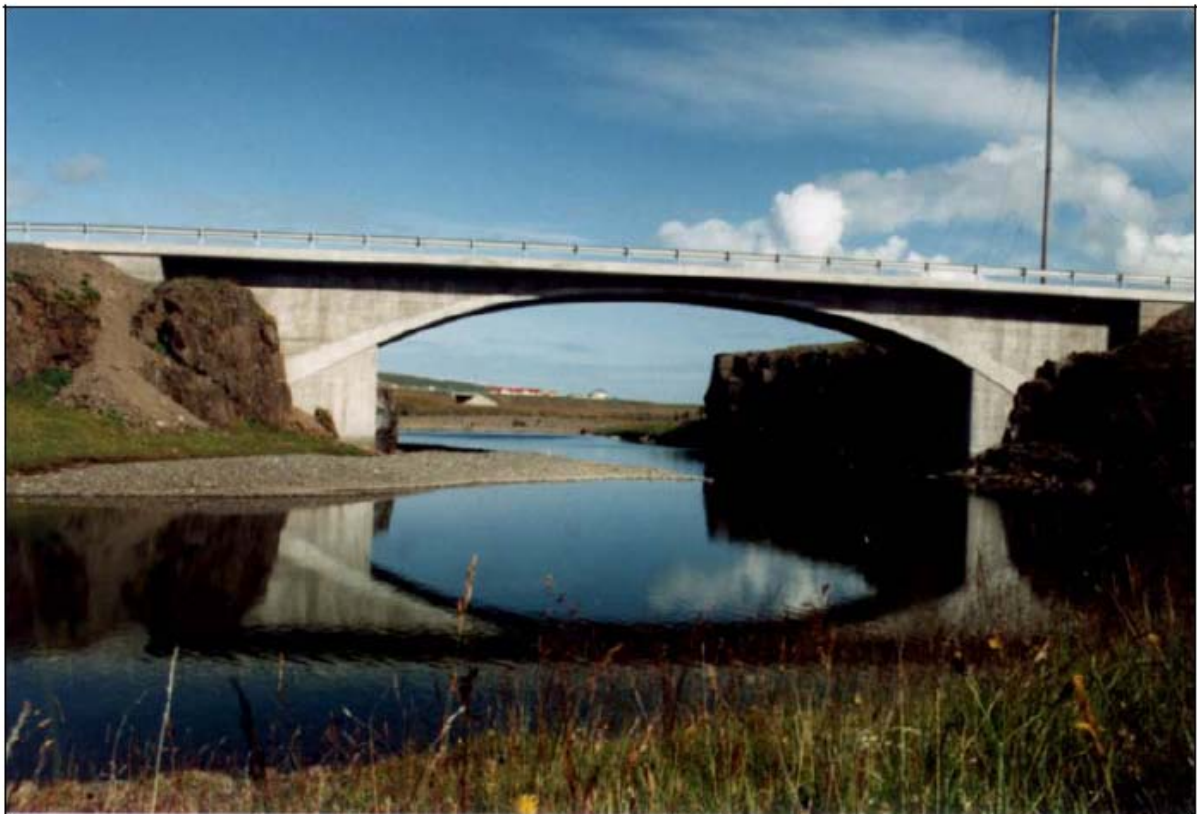
Mynd 37. Núverandi brú yfir Hrútafjarðará [Gunnar H. Jóhannesson, 2006].
