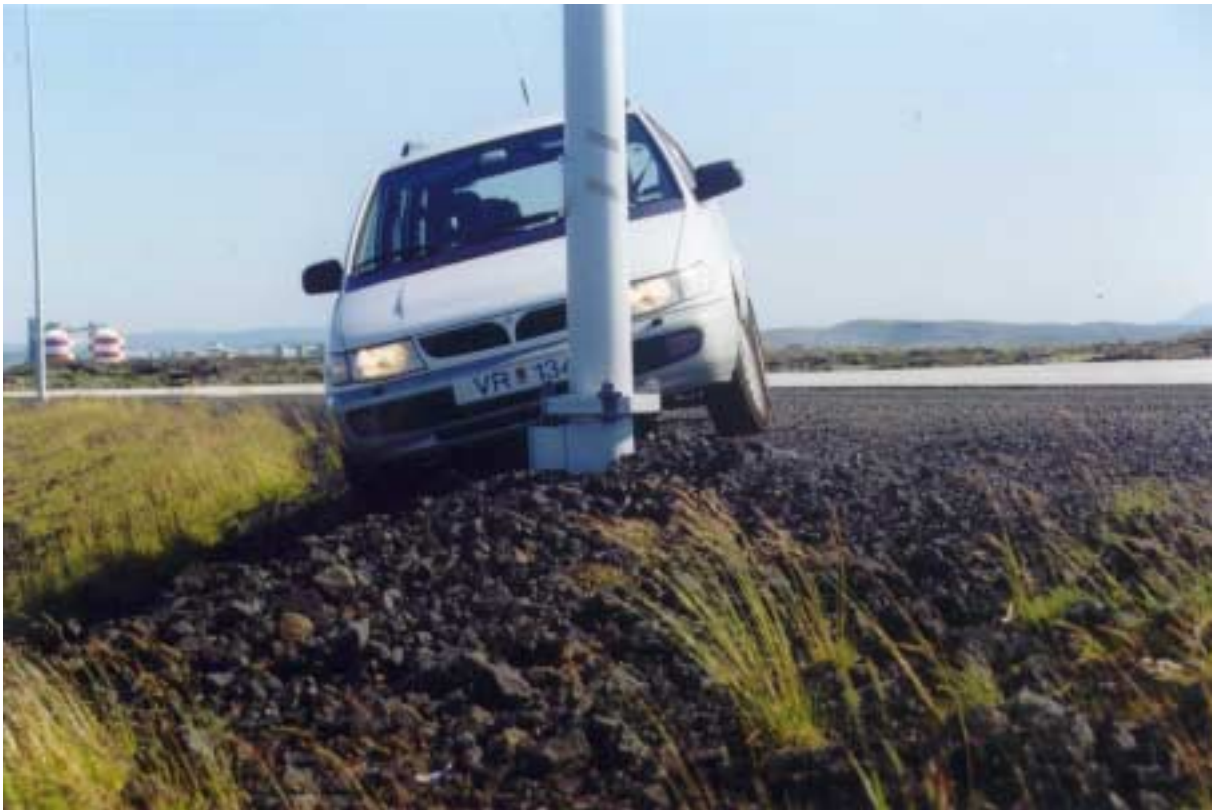
Mynd 1. Ljósastaur á Reykjanesbraut.
