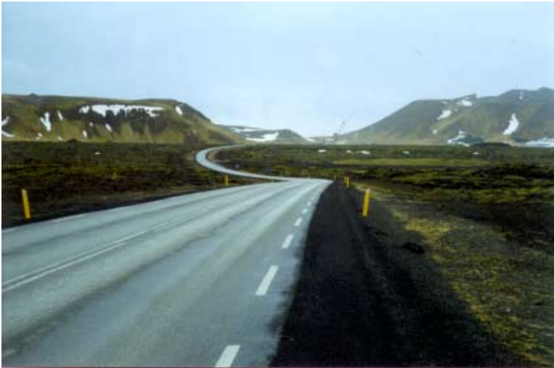
Mynd 4. Grindavíkurvegur á Gíghæð horft suður.
