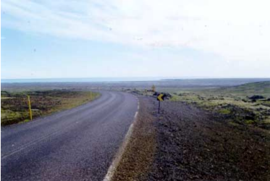
Mynd 31. Þrengslavegur við Lyngbrekkur séð frá norðri.
