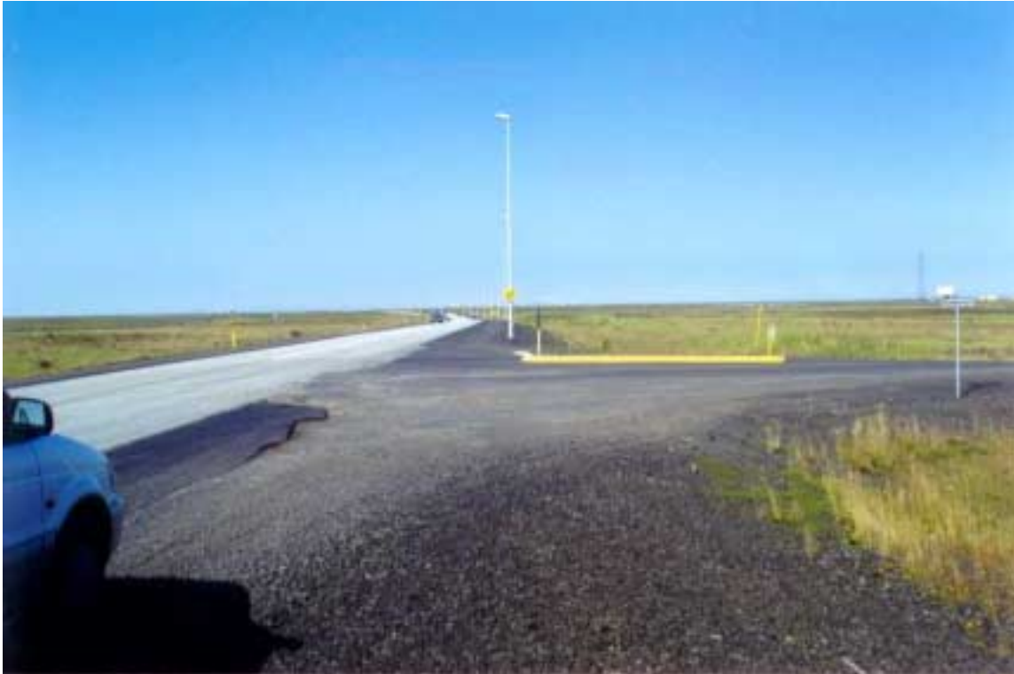
Mynd 6. Vegamót Reykjanesbrautar og Flugvallarvegur séð frá austri.
