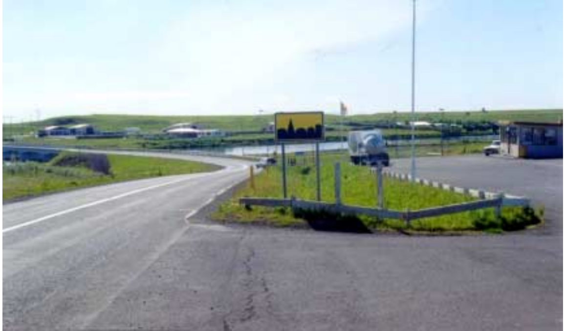
Mynd 29. Suðurlandsvegur vestan við Hella.
