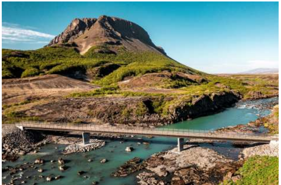
Mynd 6-35 Ný 102 m löng reið- og göngubrú yfir Þjórsá ofan við Þjófafoss. Timburgólf úr íslensku sitkagreni er lagt á stálbita. Mynd, Landsvirkjun, Búrfell í baksýn.
