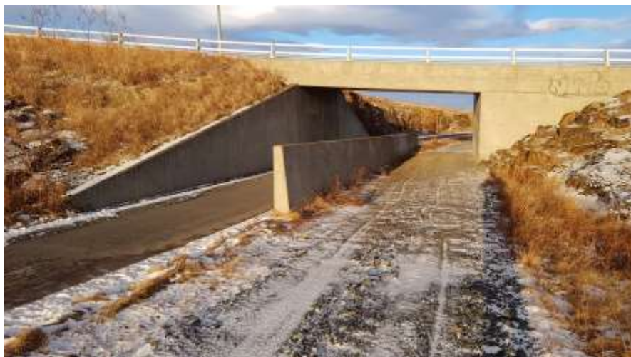
Mynd 6-16 Steypt göng undir tengingu Víkurvegjar við Vesturlandsveg. Heildarbreidd ganga er 5 m, hér hefur verið settur upp veggur til að skilja að umferð ríðandi manna frá annarri umferð, breidd reiðstígs er 3 m og lofthæðin er einnig 3 m.
