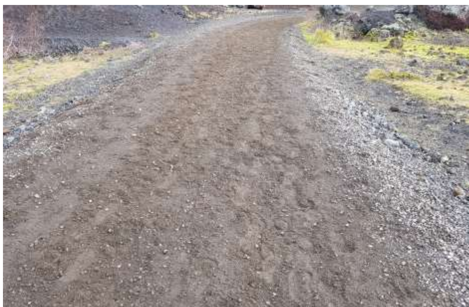
Mynd 9-2 Frágenginn reiðstígur, uppbyggður með styrkingarefni, unnið reiðstígaefni sem slitlag og grjóthreinsaðir fláar.
