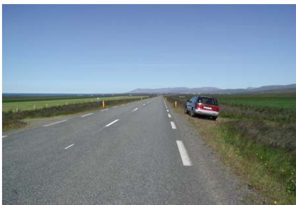
1 k9-03 Hringvegur, sunnan við Blönduós
