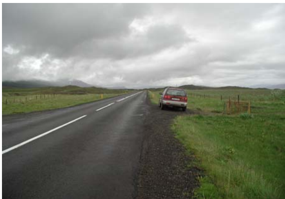
1 t4-02 Hringvegur í Skriðdal
