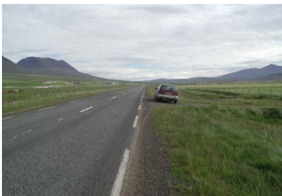
1 m8-01 Hringvegur, Blönduhlíð
