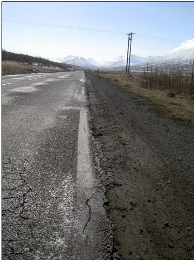
Mynd 5. Vegur er eru víða illa farnir. Hér sést ónýtt slitlag í vegkanti ofan við vantsból að Vöglum. Horft suður Hörgárdal (SJ. 2008).
