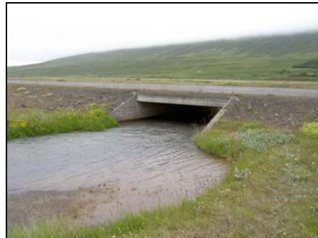
Mynd 7. Brú yfir Fossá (SJ, 2008).
