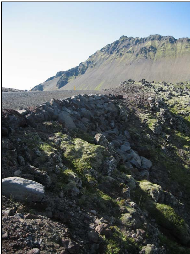
Mynd 56. Góður frágangur á fyllingafláa norðan vegar með hlöðnum hraunvegg (H.A., ágúst 2007).
