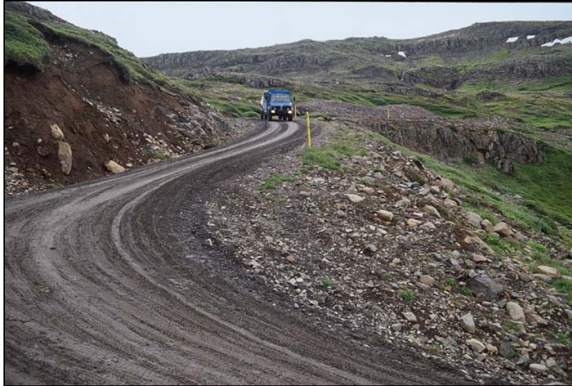
Mynd 62. Mjóafjarðarvegur, miklar, ógrónar skeringar (Ljósmynd: Viktor Arnar Ingólfsson).
