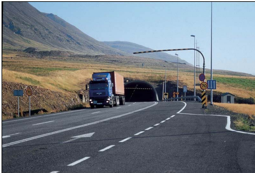
Mynd 67. Hringvegur um Hvalfjarðargöng. Skeringar illa grónar og falla illa að aðliggjandi landi (Ljósmynd: V.A.I.).
