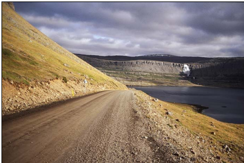
Mynd 63. Vestfjarðarvegur við Dynjandisvog. Skörp skil skeringar og aðliggjandi lands (Ljósmynd: V.A.I.).
