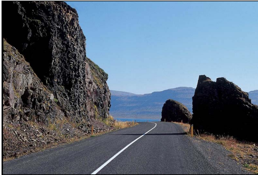
Mynd 64. Barðastrandarvegur um Raknadalshlíð við Patreksfjörð. Hættulegir kubbabergsstapar skildir eftir við vegaf framkvæmdir, líklega í kringum 1960, að eindregnum óskum heimamanna. Þegar vegarkafllinn var endurbyggður á níunda áratugnum gerðu heimamenn kröfur um að ekki yrði hreyft við Stöpunum og var því klippt á bergið til vinstri til að auka rýmið. Í dag myndu vera hönnuð vegrið á stað þar sem svona háttar til (Ljósmynd: Viktor Arnar Ingólfsson).
