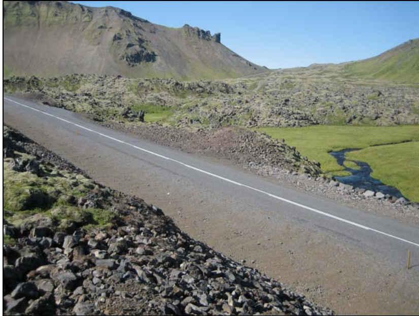
Mynd 55. Horft frá skeringarbrún sunnan vegar að skeringu og fyllingu norðan hans (H.A., 2007).
